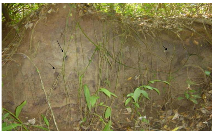
Figura 5.25: Vazios (fenômeno “piping”) no solo que margeia o corpo de água.
