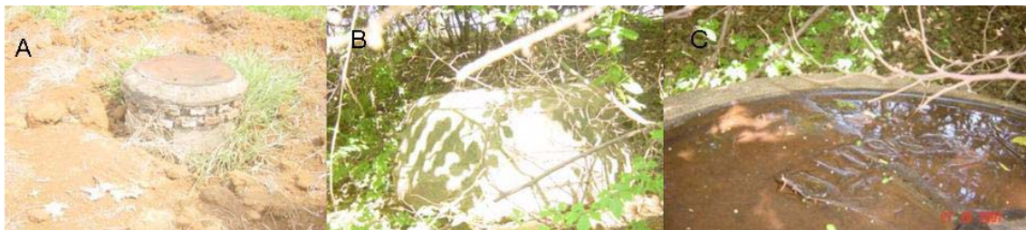
Figura 5.10: A/B Presença de PVs de esgoto na área analisada C- Destaque da tampa com a denominação Esgoto.
