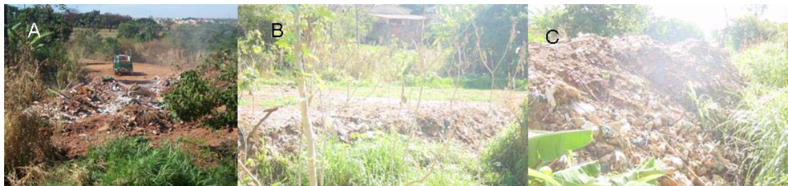
Figura 5.14: A- Caminhão depositando entulho; B- Ponto de grande acumulação de entulho; C- Visão aproximada deste.
