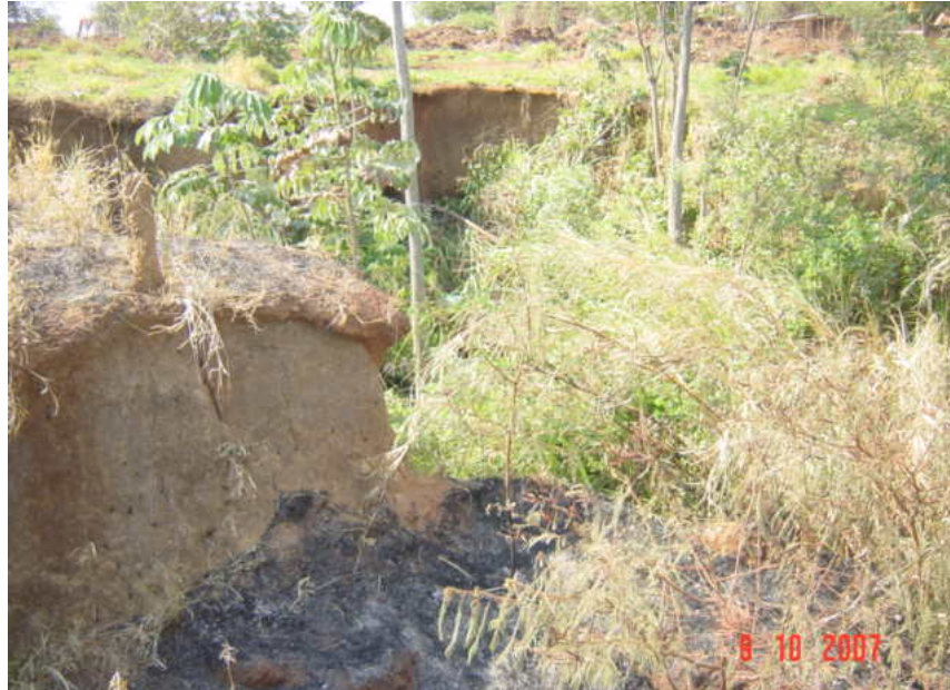
Figura 5.33: Visão da Voçoroca 1
