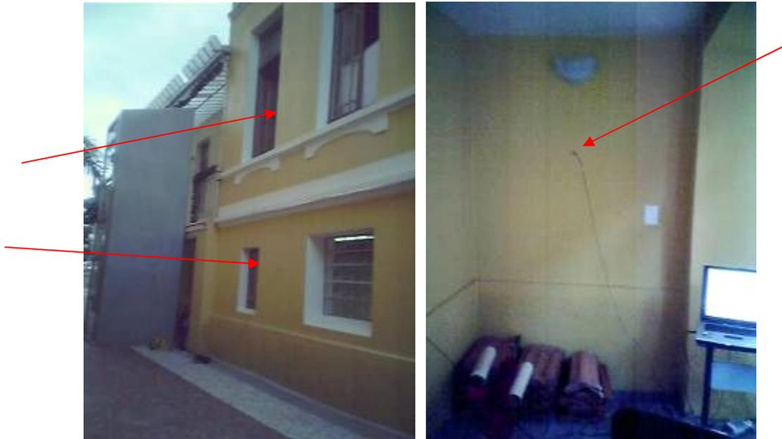
Figura 4.8 - Localização dos acelerômetros – parede paralela (térreo e primeiro pavimento) e parede perpendicular (térreo) – Segunda medição.
