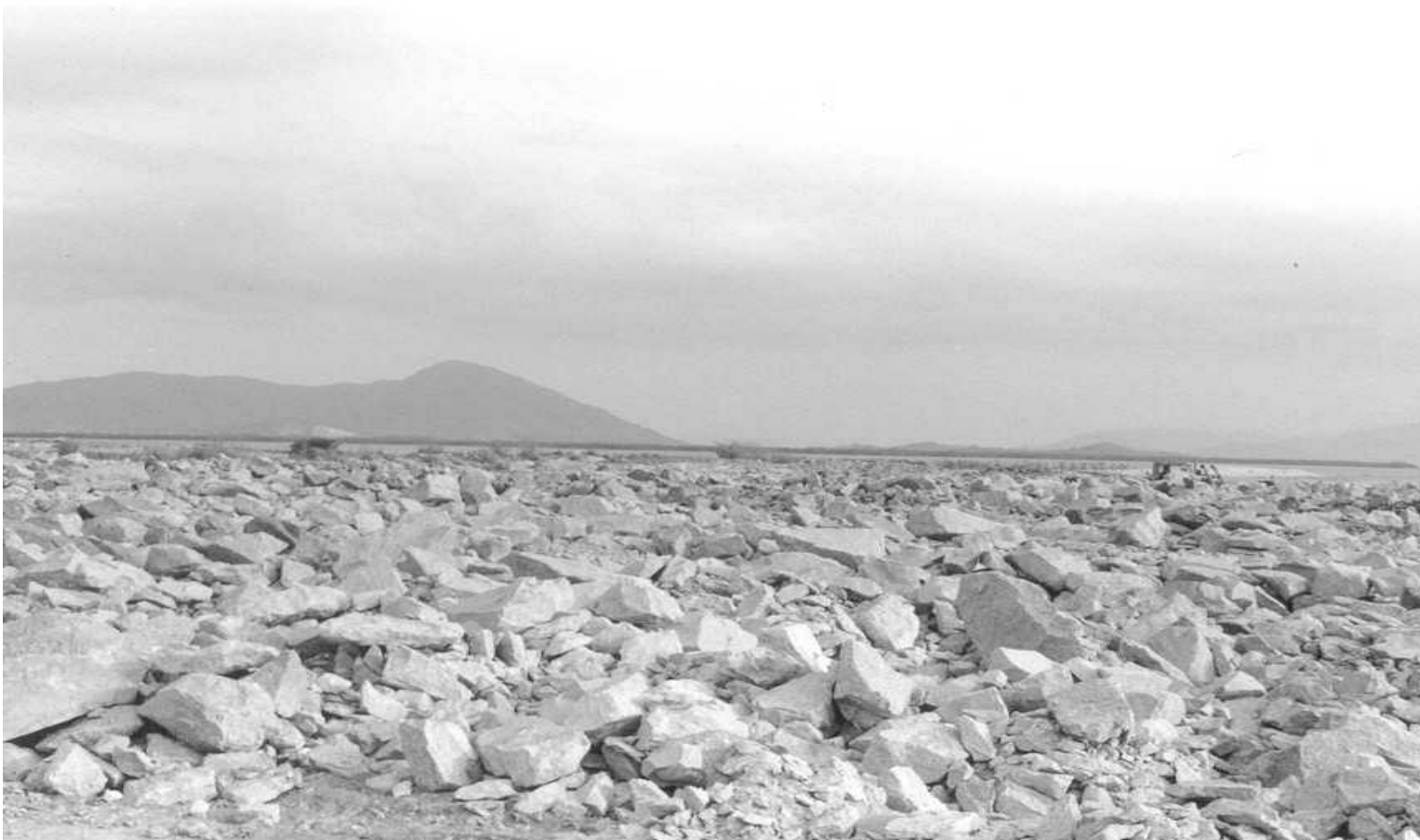
Figura 05 - pedras retiradas da construção do túnel, utilizadas como camada no aterro da via expressa sul, 1997 – acervo digital da casa da memória – Fpolis.
