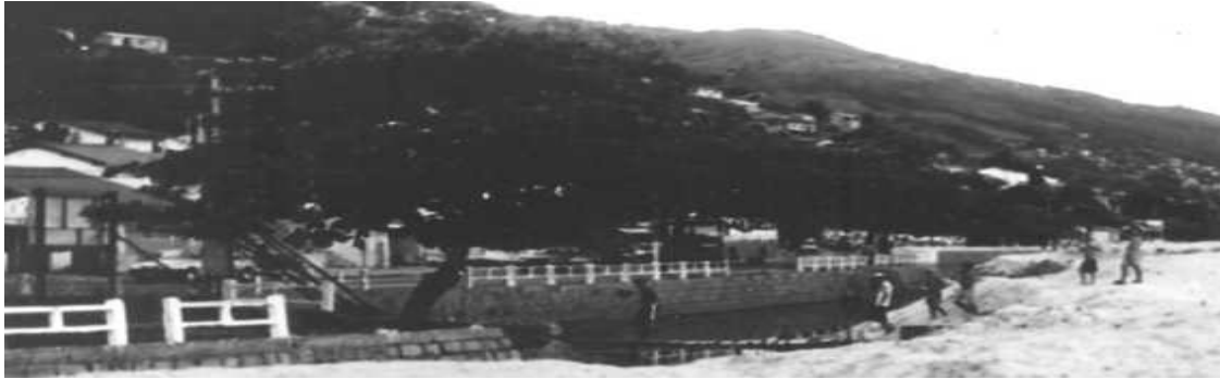
Figura 03 - passagem clandestina criada pela comunidade ao aterro abandonado , 1998
