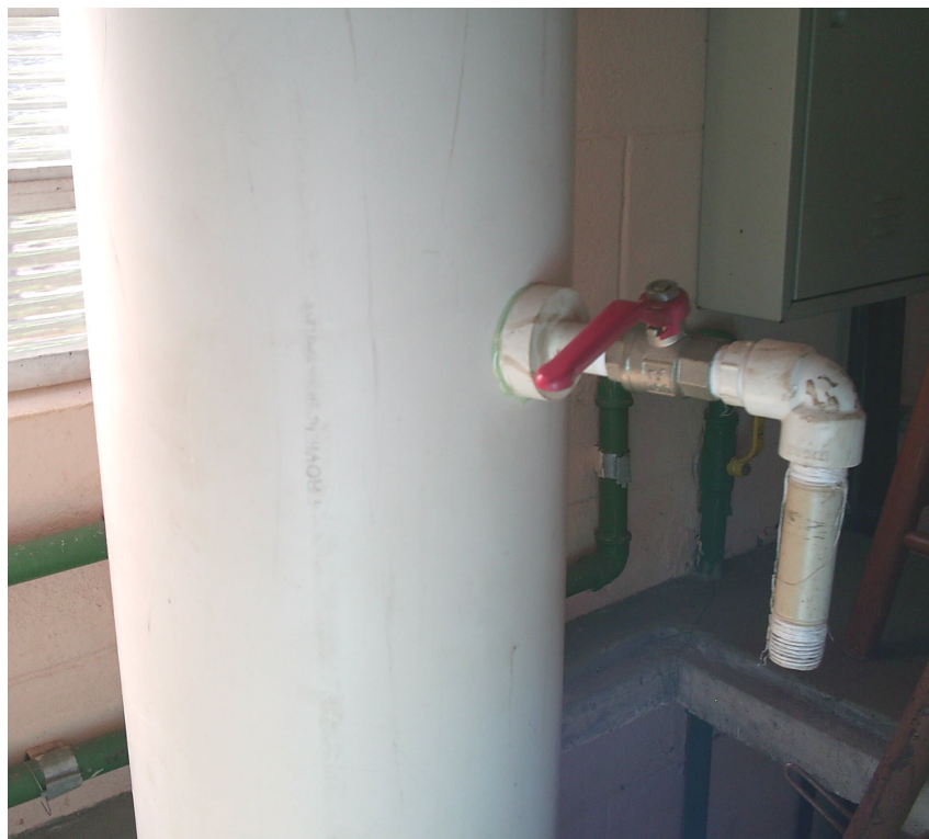
Figura 5.4: Detalhe da torneira para retirada de amostra do reator
