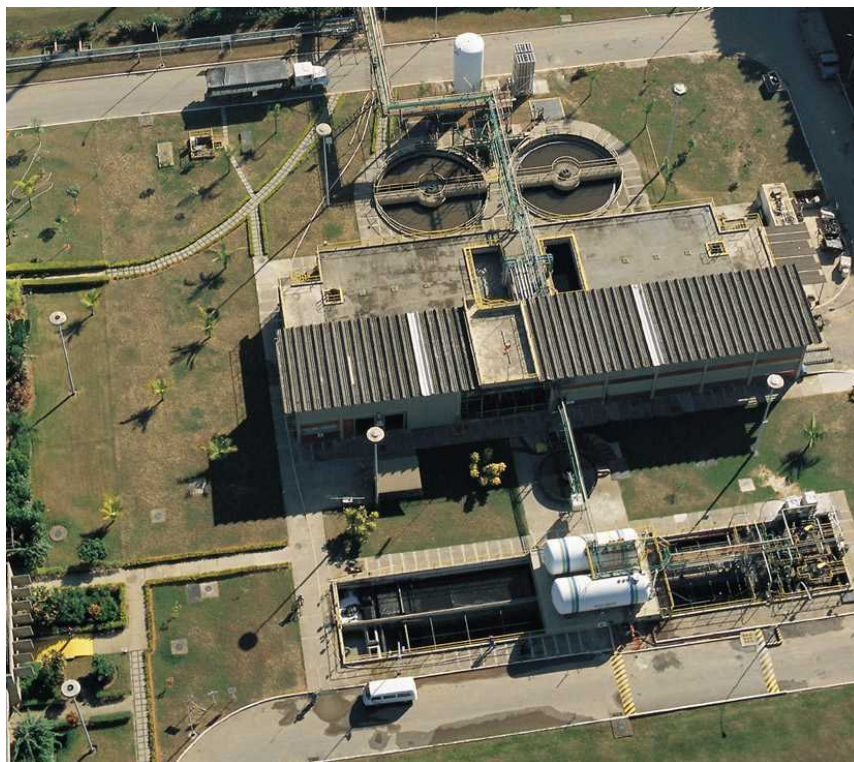
Figura 12: Estação de Tratamento de Resíduos Industriais (ETDI) (Fonte: TRIBEL S.A.).
