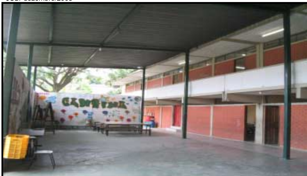
Ilustração nº 20- Ampliação da construção original e escola pública, com inserção de elemento de cobertura de pátio-Escola Estadual Francisco Brant - Belo Horizonte- MG
