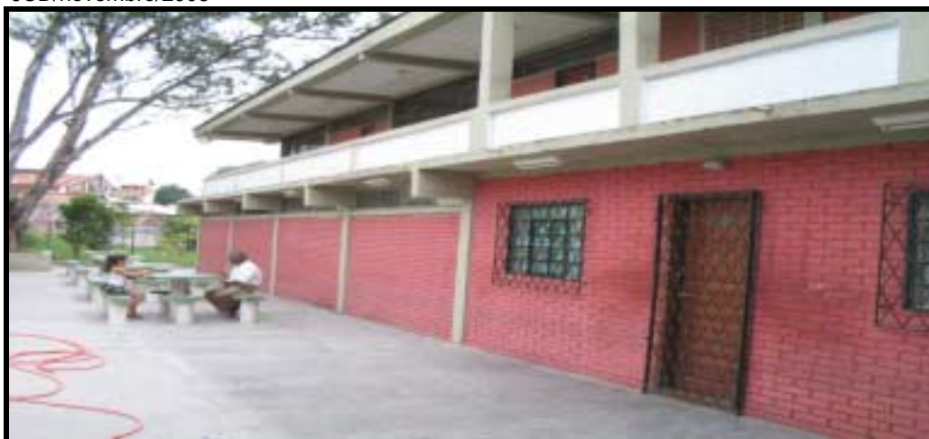
Ilustração nº 04- Fachada da Escola Estadual Francisco Brant - Belo Horizonte –MG
