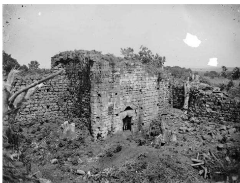
Fotografia 69 - Situação da sacristia antes da remoção do material remanescente [s.d.]. ANS.
