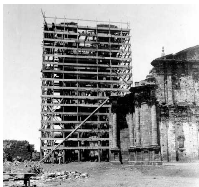
Fotografia 66 – Andaimos para intervenção na torre, durante a obra do SPHAN. ANS.
