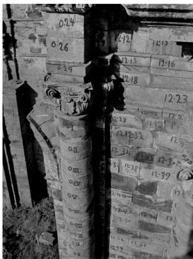
Fotografia 68 - Numeração das pedras nas alvenarias que foram desmontadas na obra dirigida por Mayerhofer. ANS.
