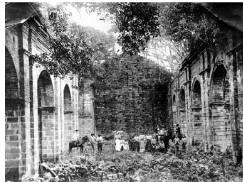
Fotografia 74 - Visitantes a cavalo no interior das ruínas [s.d.]. ANS.
