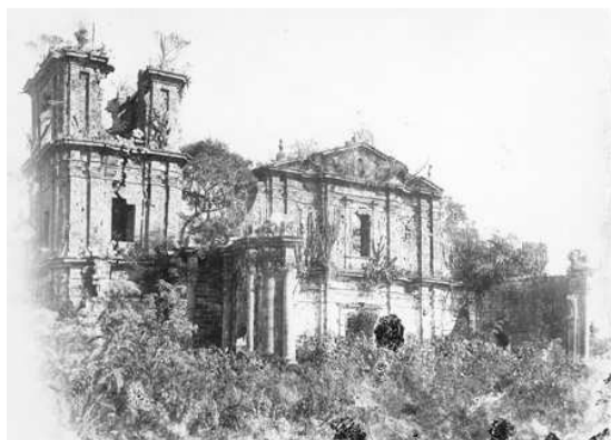
Fotografia 51 - As ruínas da Igreja de São Miguel Arcanjo antes das obras de estabilização. Arquivo IPHAN/RS.
