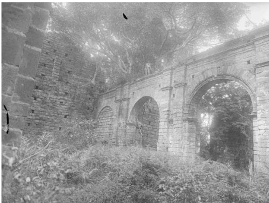
Fotografia 79 - A situação da nave antes das obras de consolidação do governo do Estado [s.d.]. ANS.
