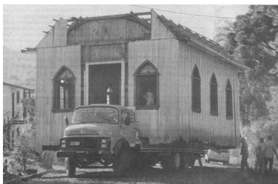
Fotografia 97 - Igreja sendo transportada em cima de um caminhão em Paulo Bento, no RS. Foto: M. Ferreira, 2006. 114
