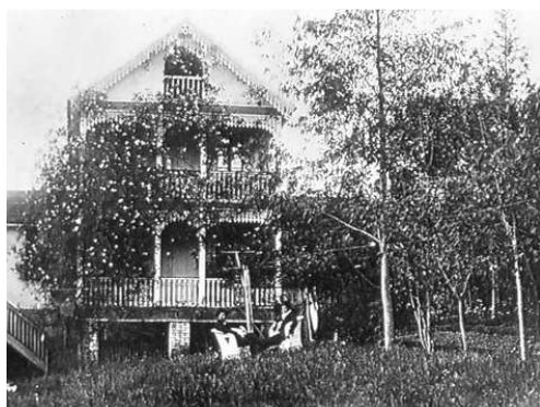
Fotografia 91 - A fachada posterior da Casa dos Paim, ornamentada com lambrequins [s.d.]. Arquivo IPHAN/RS.
