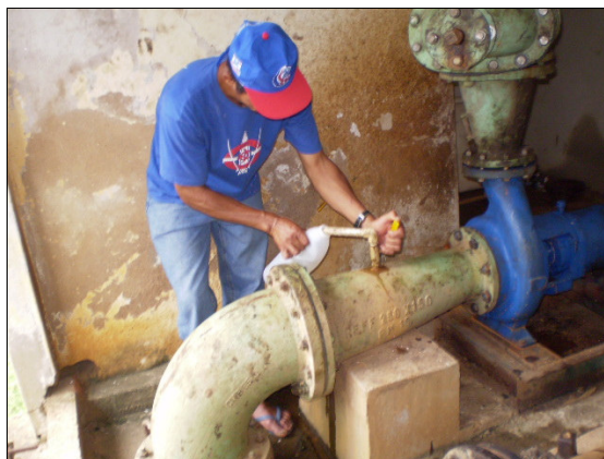
Figura 6: Coleta de amostras na casa de bombas.
