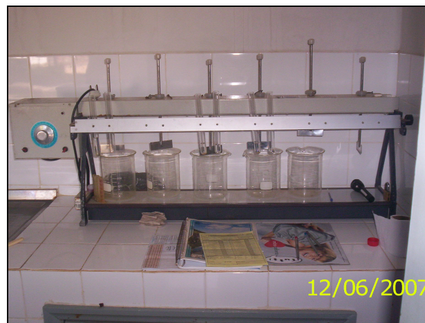
Figura 21: Equipamentos de monitoramento da ETA fora de uso.
