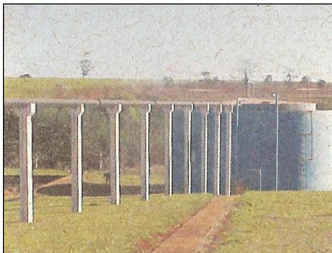
Figura 4: Reator UASB. Fonte: Menezes (2005).
