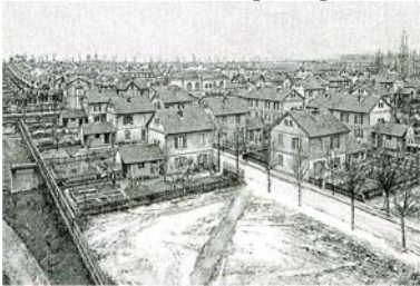
FIGURA 13- Casas dos operários da fábrica de chocolates Menier.
