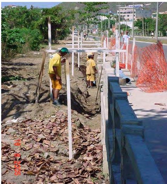
Figura 40: Instalação da rede coletora de esgotos no Recreio dos Bandeirantes (PREFEITURA DO RIO, 2006)
