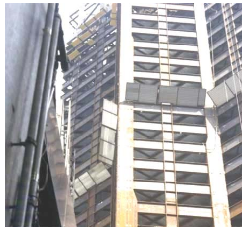
Figura 2.7 – Exemplo de utilização em edifícios
