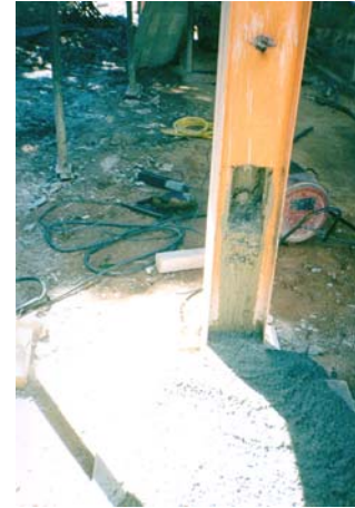
Figura 2.9 – Preenchimento do pilar
