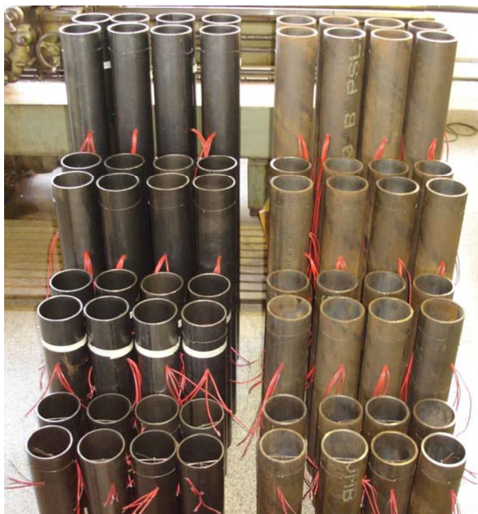
Figura 5.30 – Todos os 64 pilares prontos para a concretagem
