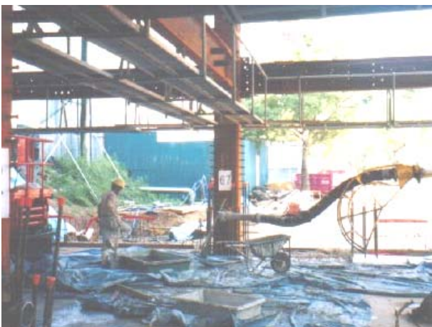
Figura 2.6 – Preenchimento do pilar
