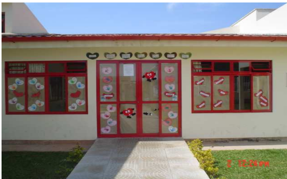
Fotografia 2 - Entrada Principal da Creche
