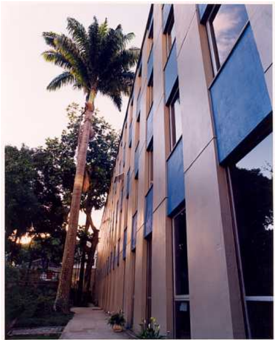
2. Fundação Casa de Rui Barbosa – Prédio anexo
