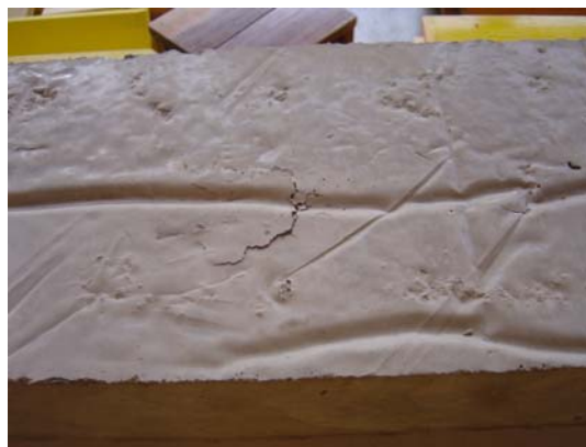
b) Esmagamento da parte superior da mesa de concreto da viga
