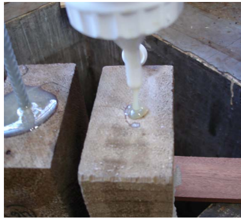
Figura 3.7: Aplicação da resina poliuretana Purweld 665.
