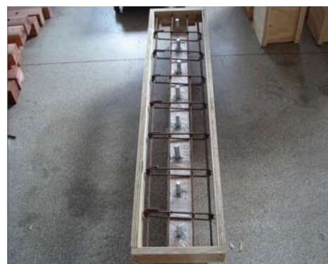
b) Detalhe da armadura para as vigas com conectores “verticais”
