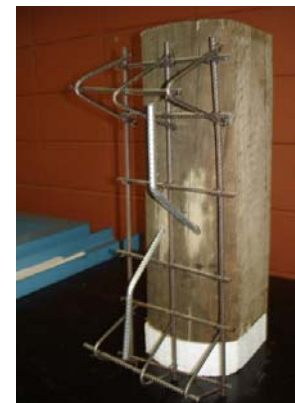
c) Detalhe da armadura utilizada no concreto
