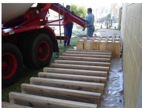
c) Lançamento do concreto durante a concretagem das vigas
