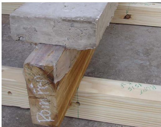
a) Ruptura na alma da viga mista por cisalhamento na linha neutra (LN)
