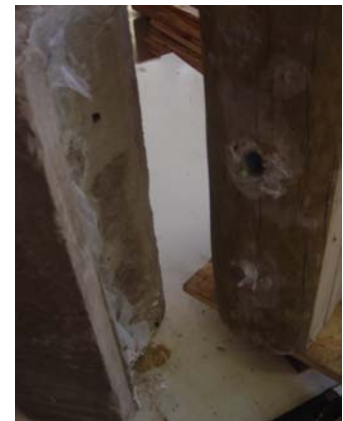
d) Embutimento na madeira e ruptura da conexão para 768.089 ciclos (CP01-VR1)
