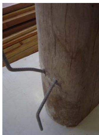
b) Detalhe do conector “X” após a aplicação de 2x10 6 ciclos de carga.
