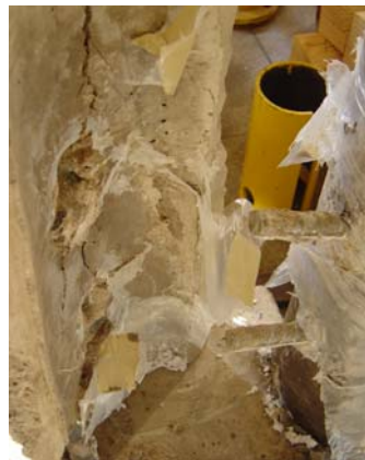
c) Fissuração no concreto após ensaio estático até a ruptura (CP03-VR1)
