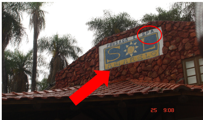
Foto 4: Fachada da pousada Sol Amarelo Fonte: Levantamento de Campo 25/10/2006
