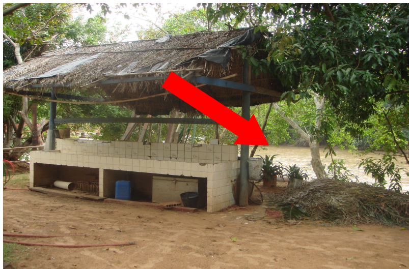
Foto 9: Mata ciliar inexistente e construções irregulares Fonte: Levantamento de Campo 25/03/2007
