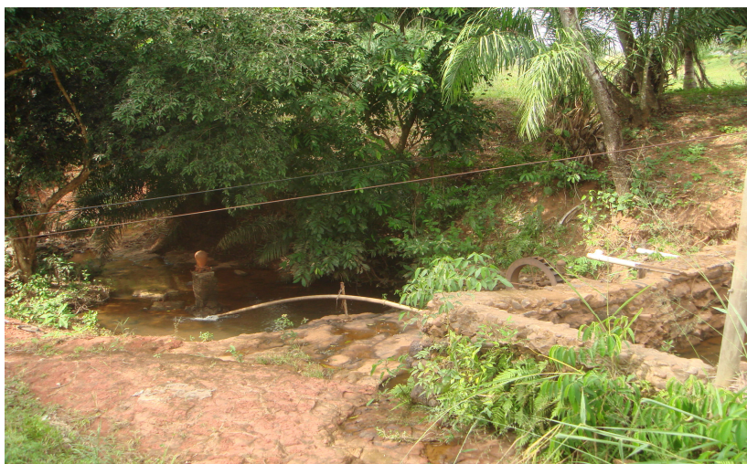
Foto 18b : Mosaico dos danos causados pela construção ilegal de represa/ Pesqueiro 110 Fonte: Levantamento de Campo 25/10/2006 e 25/03/2007
