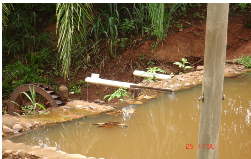
Foto 18d : Mosaico dos danos causados pela construção ilegal de represa/ Pesqueiro 110 Fonte: Levantamento de Campo 25/10/2006 e 25/03/2007
