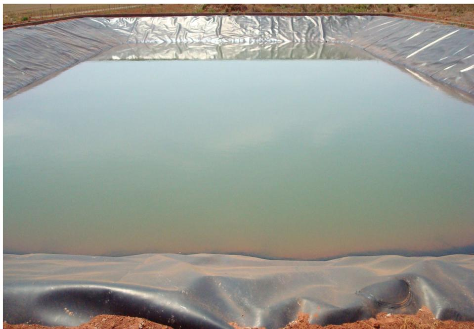
**Figura 10:** Lagoa impermeabilizada para armazenagem de manipueira
