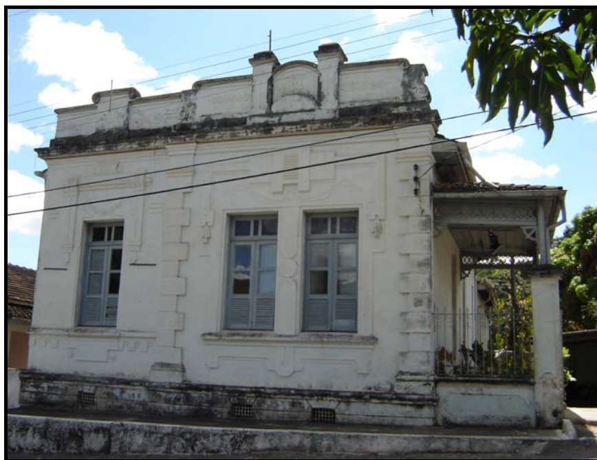
Foto 15: Fachada frontal da residência construída para o Cel. Américo Data: 25/04/2007. Autor: Bruno de Araújo Mendes
