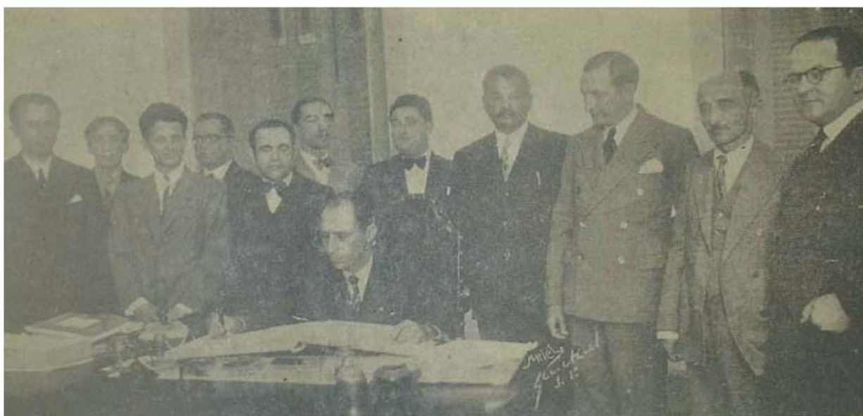
45. Assinatura do contrato entre o Escritório Saturnino de Brito e o Governo do Estado da Paraíba para a instalação dos serviços mecanizados de abastecimento de água e coleta de esgotos de Campina Grande. Sentado, o engenheiro sanitaria Saturnino de Brito Filho. Em pé, o terceiro da direita para a esquerda, o interventor Argemiro de Figueiredo. Fonte: Jornal A União 26 jun. 1936.
