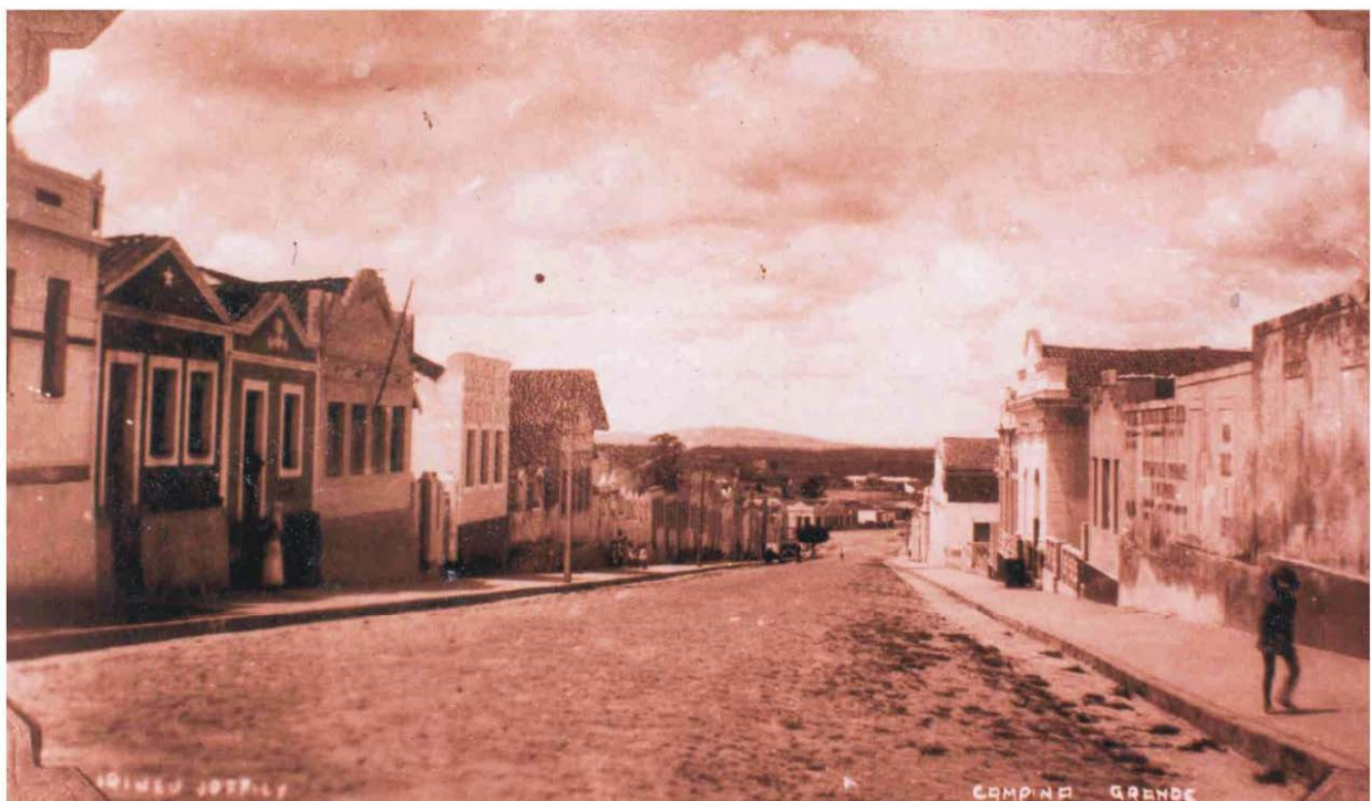
49. Com a terraplanagem, a construção de calçadas e a pavimentação da rua Irineu Joffily (foto abaixo - início dos 1930), as águas das chuvas passaram a escoar, em direção ao Açude Velho, pelas calhas executadas nos cantos da via, sem a abertura de sulcos que outrora acumulavam lixo (foto acima - 1930). Fonte: Arquivo pessoal Severino Cabral Filho.
