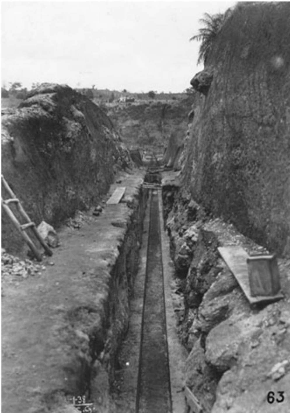
46. A engenharia desafiando e subvertendo a natureza na busca pela transformação do meio. Instalação dos serviços de saneamento de Campina Grande. Foto de 1938. Fonte: Arquivo Humberto Nóbrega - Unipê (Acervo pessoal Francisco Sales Trajano Filho).
