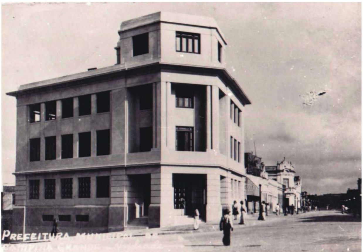
95. Acima, "arcabouço do Palácio da Municipalidade", edifício construído com estrutura independente de concreto armado. Abaixo, obra em etapa de finalização, foto do começo da década de 1940 (perceber ausência de esquadrias no 2º. Pavimento). Esquina entre a rua Maciel Pinheiro e a avenida Floriano Peixoto. Fontes: Jornal A União , 21 set. 1941. Arquivo pessoal Severino Cabral Filho.
