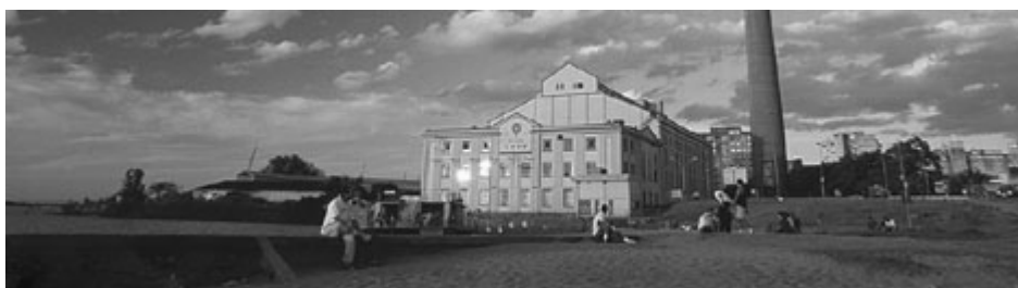
Figura 10 - Vista da Usina do Gasômetro junto ao Rio Guaíba - Porto Alegre Fonte: www.portoalegre.rs.gov.br , 2007
