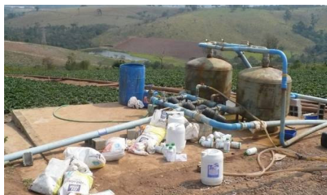
Figura 43 – Vasilhames de produtos químicos e biológicos a céu aberto
