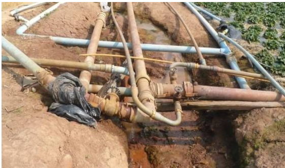
Figura 78 – Canos por onde passam o veneno e a água utilizada na lavoura.
