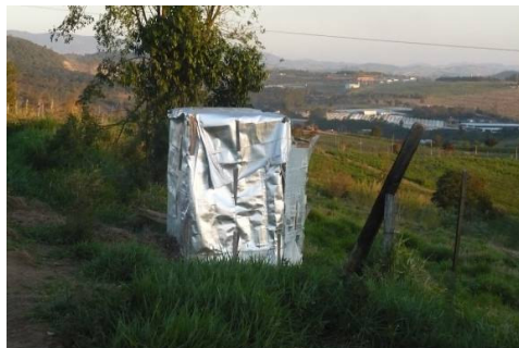
Figura 26 – Vista externa do sanitário/privada utilizado pelos trabalhadores
