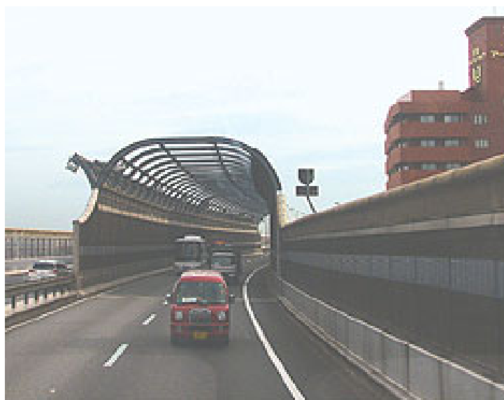
Figura 3.5: Túnel falso em Osaka, Japão, usado para proteger o prédio à direita, evitando que a implantação de barreiras muito altas causassem grande impacto visual
