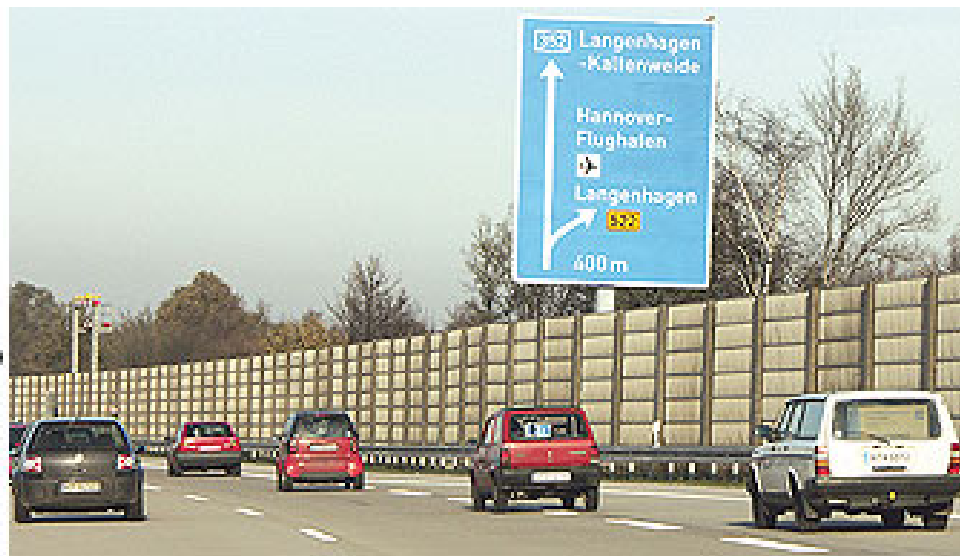
Figura 3.4: Barreira acústica instalada em rodovia que liga a cidade de Hanover, na Alemanha, a seu aeroporto
