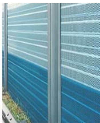
Figura 3.8: Barreira metálica, localizada em estrada entre Pádua e Veneza, na Itália
