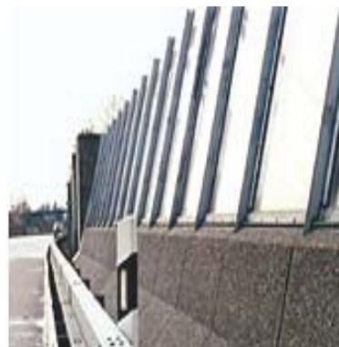
Figura 3.11: Barreira mista executada em concreto e acrílico
