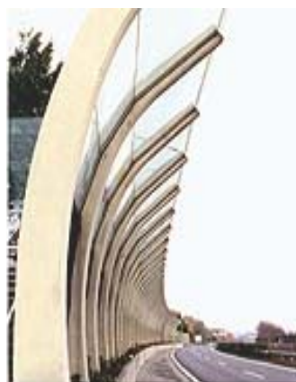
Figura 3.7: Barreira curva em concreto e acrílico, na Suíça
