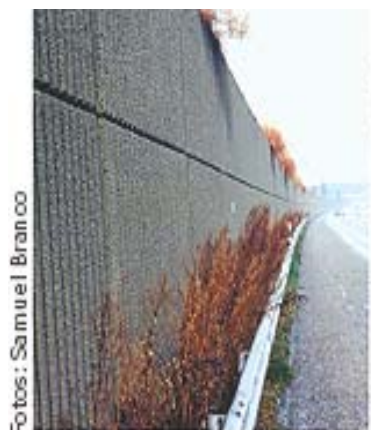
Figura 3.6: Barreira de concreto ondulada, parcialmente absorvente
