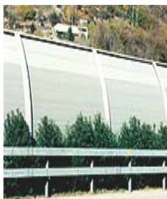
Figura 3.9: Barreira acústica metálica, instalada próxima a Zurique, na Suíça
