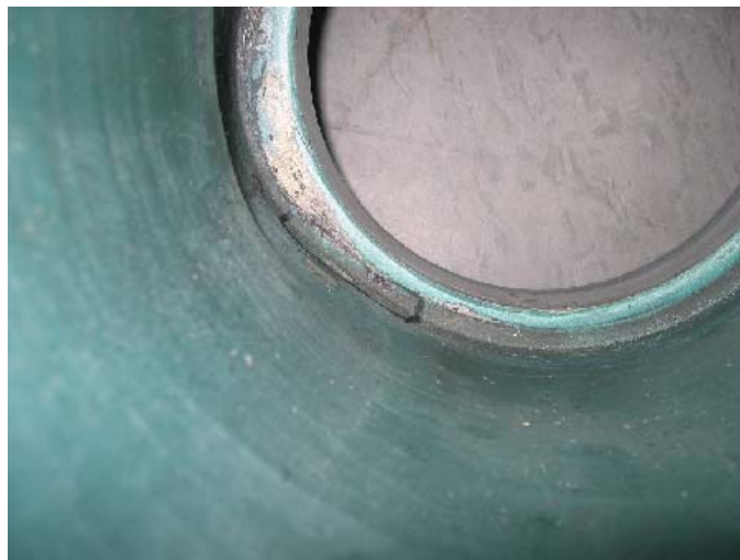
Figura 8.8 - Falha típica que ocorre no pilone do F-15 (Martin, 2004).
