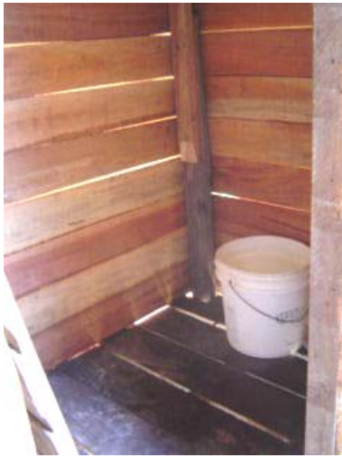
Novo banheiro da casa.
