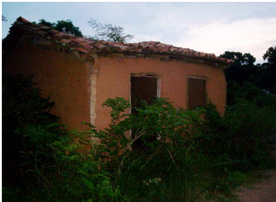
Figura 17- Casa da Memória construída em 2000 e demolida em 2007. Fonte: Arquivo da pesquisadora, ago. 2006.
