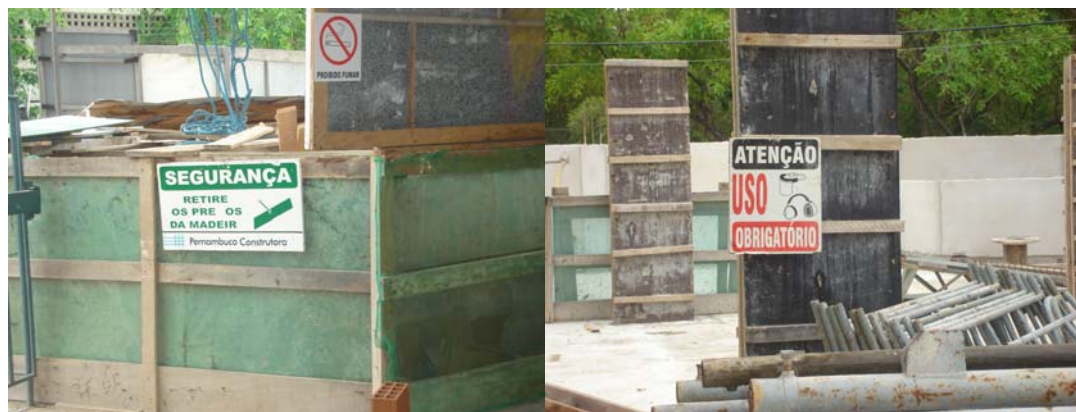
Exemplo 5 - Placas de instruções de segurança afixadas no canteiro de obras
