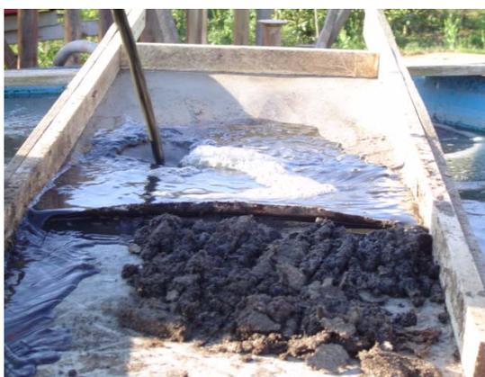
Figura 8: Tela utilizada para filtração da ARS
