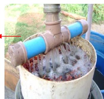
Figura 5: Detalhe da entrada ARS no filtro
