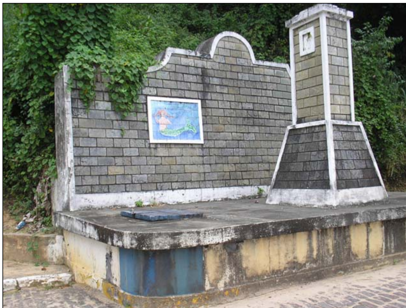
Figura 2.2: Reservatório da Fonte da Bica.
