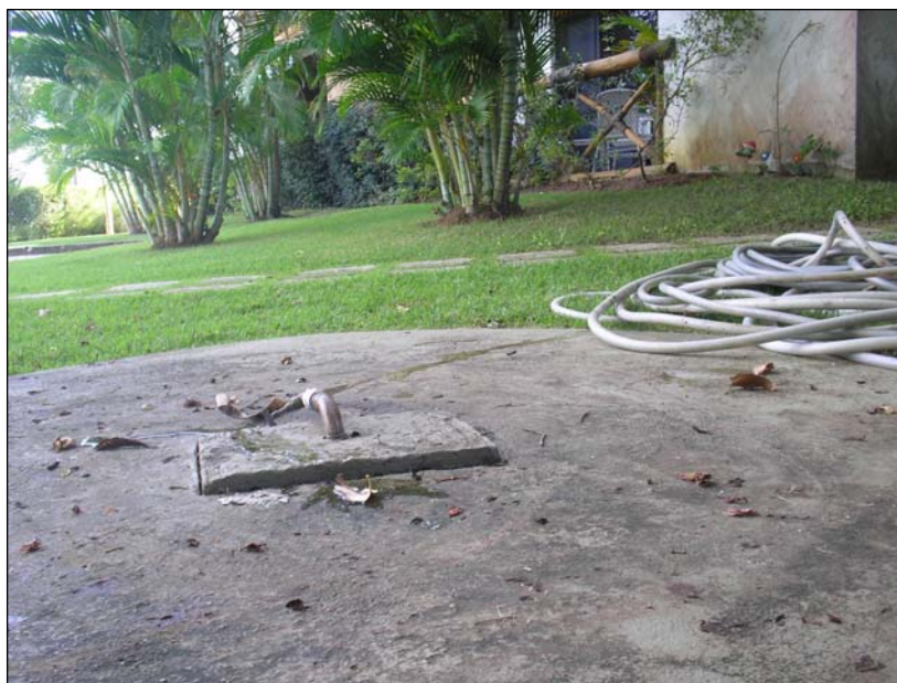
Figura 2.9: Ponto de amostragem do Condomínio Costa Oeste.
