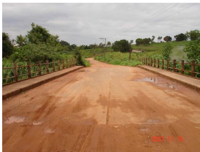
Figura 6.33 – Tabuleiro com presença de solo e lama
