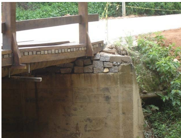
Figura 6.60 – Apoio de má qualidade para as toras de madeira
