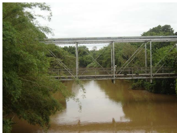
Figura 6.14 – Vista lateral da ponte
