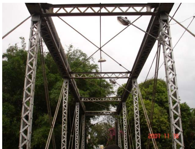
Figura 6.22 – Vista dos contraventamentos da estrutura
