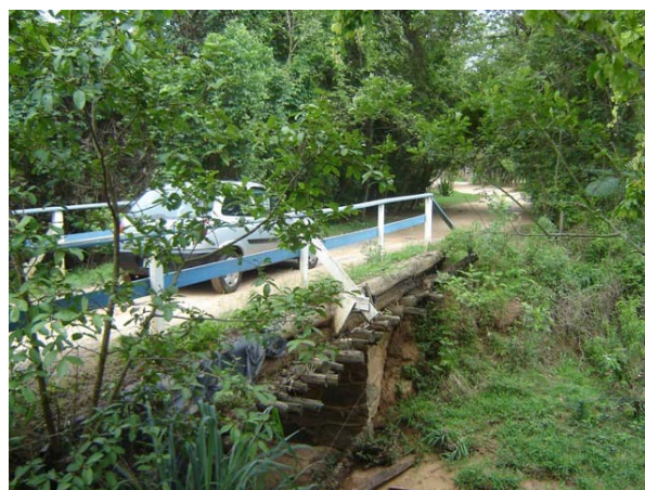
Figura 6.24 – Vista geral da ponte
