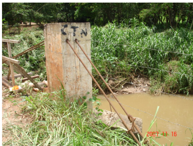
Figura 6.50 – Bloco de concreto para sustentação dos cabos de aço
