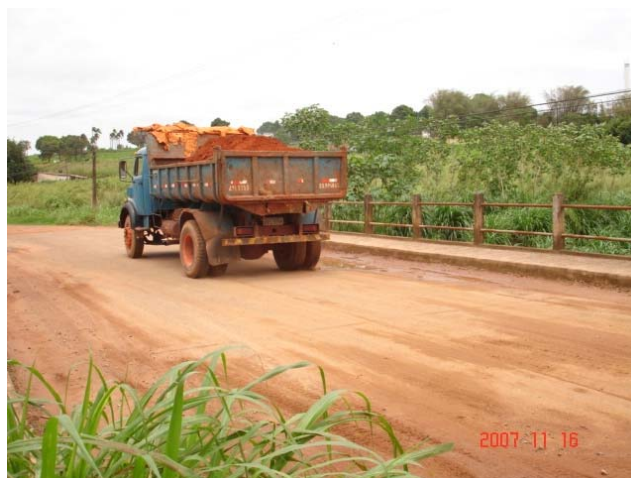
Figura 6.30 – Vista do tabuleiro da ponte
