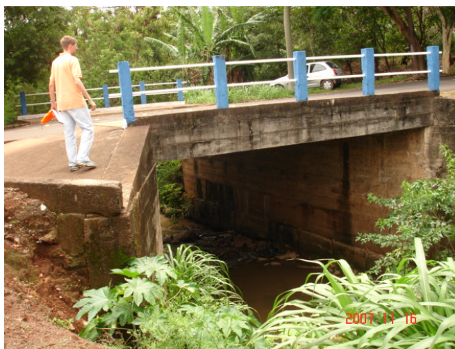
Figura 6.41 – Vista geral da ponte
