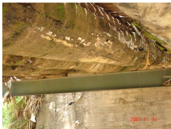
Figura 6.49 – Transversina metálica
