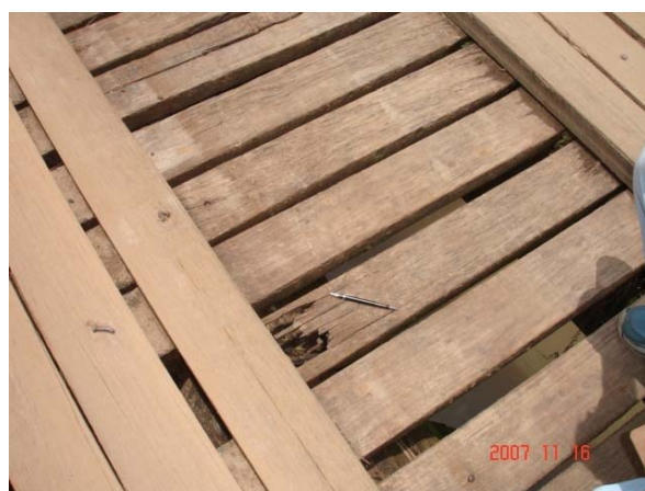
Figura 6.53 – Tábua deteriorada
