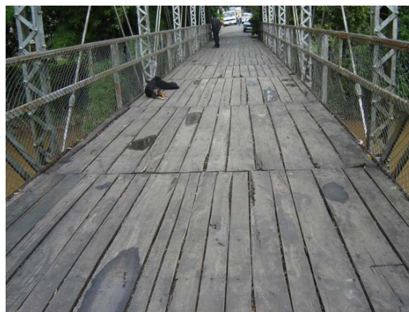
Figura 6.16 – Tabuleiro de madeira
