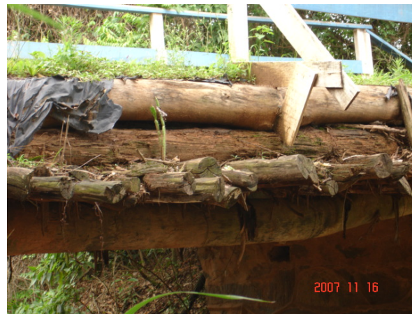
Figura 6.26 – Toras que compõem a superestrutura
