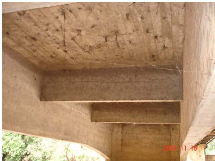
Figura 6.5 – Vista inferior da ponte
