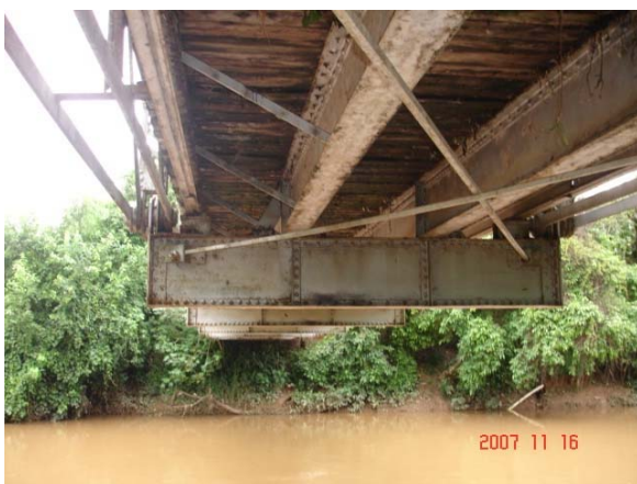
Figura 6.15 – Longarinas metálicas
