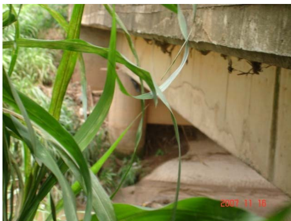
Figura 6.31 – Vista dos pilares de sustentação e das vigas principais
