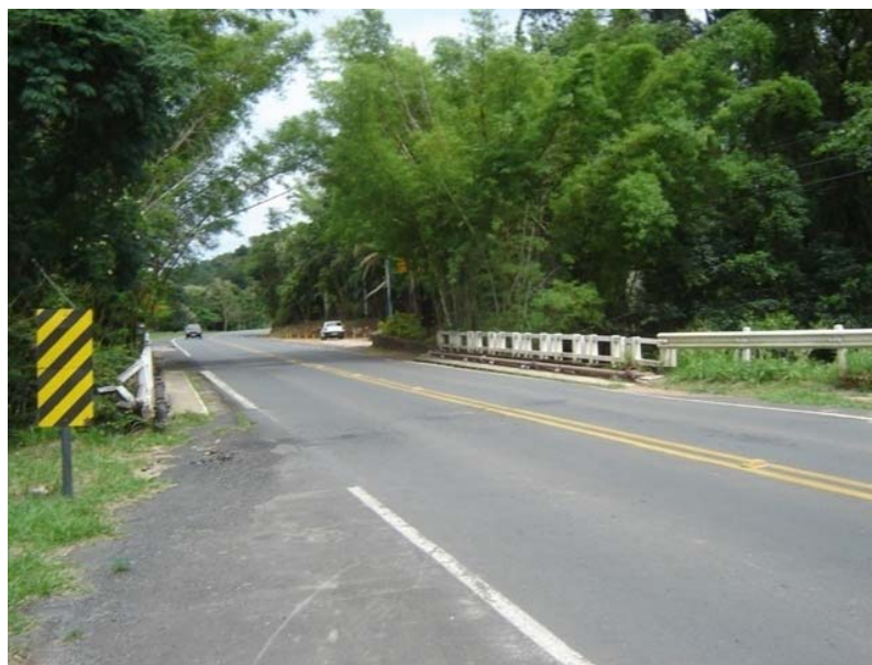
Figura 6.55 – Vista geral da ponte
