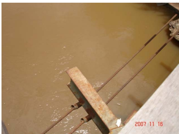
Figura 6.48 – Posicionamento dos cabos de aço na transversina metálica
