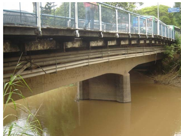
Figura 6.2 – Vista geral da ponte
