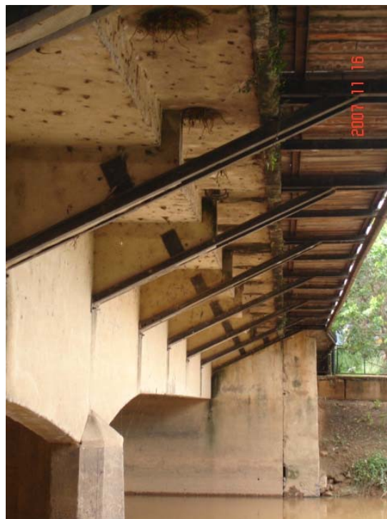
Figura 6.3 – Estrutura metálica que sustenta o passeio
