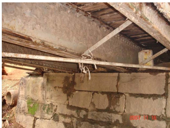
Figura 6.17 – Encontros de blocos de pedra assentados com argamassa
