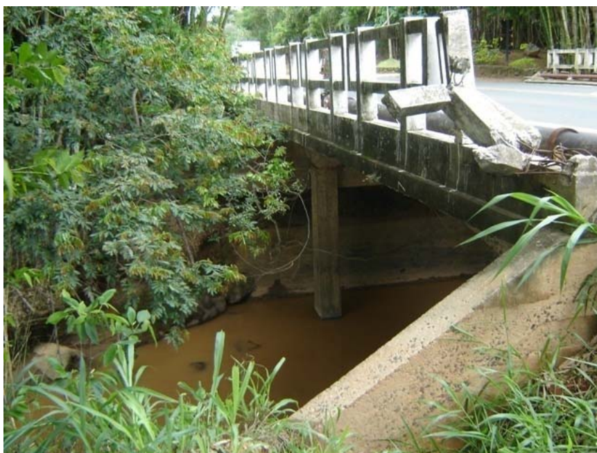
Figura 6.56 – Vista geral da estrutura da ponte
