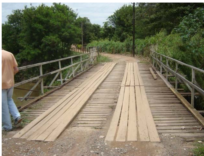
Figura 6.54 – Vista geral da ponte e dos guarda-corpos
