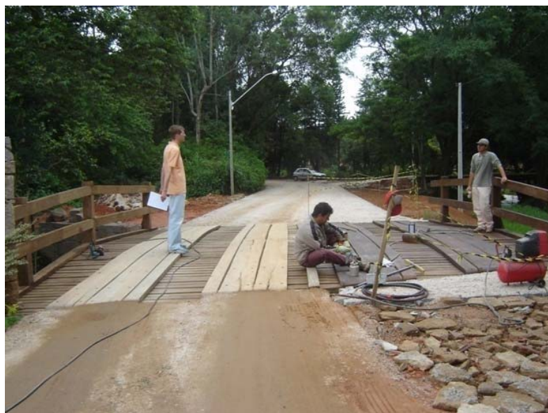
Figura 6.59 – Ponte de madeira em fase de acabamento
