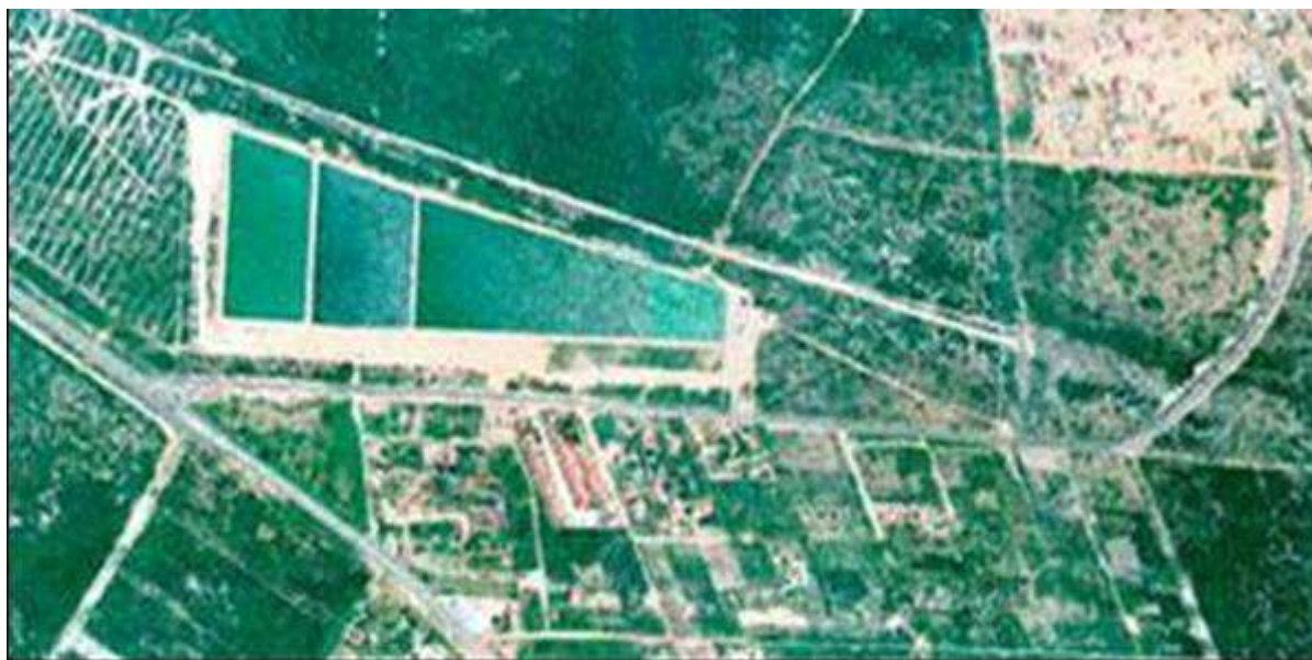
Figura 4.1 Sistema de Tratamento de Efluentes de Ponta Negra – Natal – RN.
