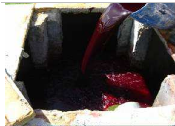
Figura 4.11 Injeção do corante na caixa de distribuição.
