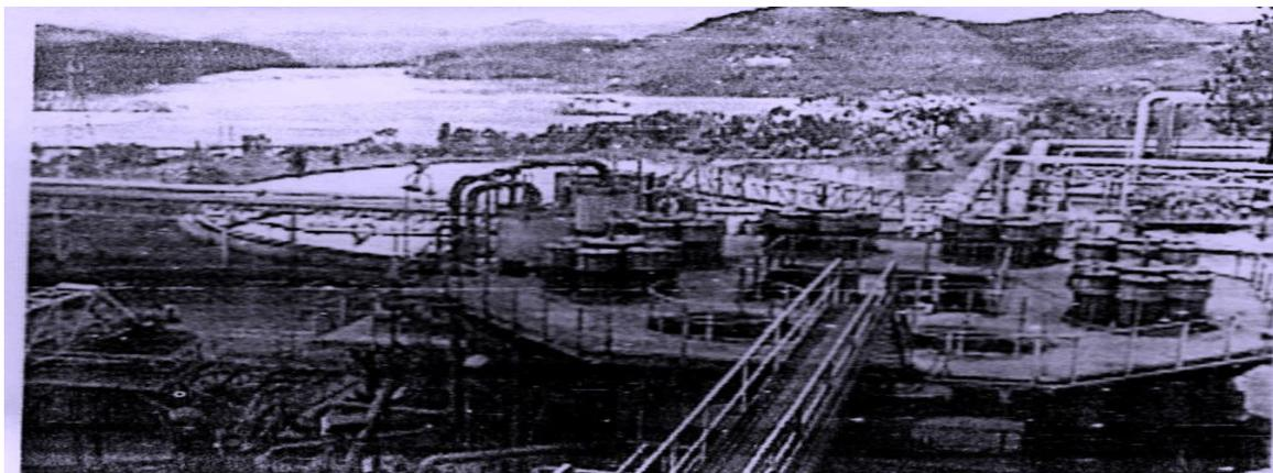
Figura-5a: Detalhes do circuito de flotação e espessamento das lamas e, ao fundo, vista parcial da barragem de rejeitos (Monte *et al.*, 2001).
