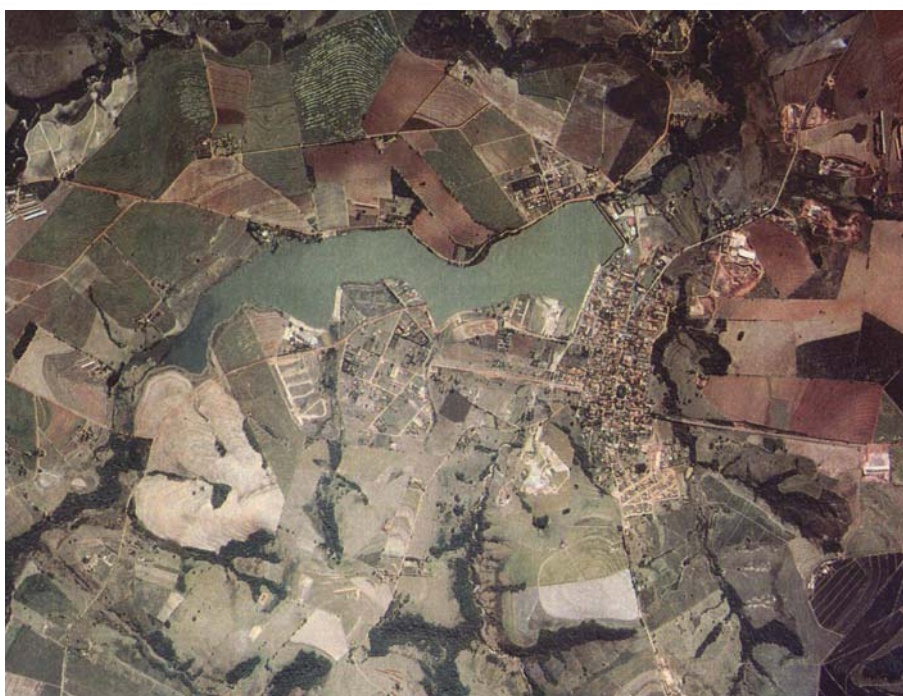
FIGURA 7 – Vista aérea da Represa Euclides Morelli Fonte: BASE AEROFOTOGRAMETRIA, 2002 (Faixa 047 n° 034).
