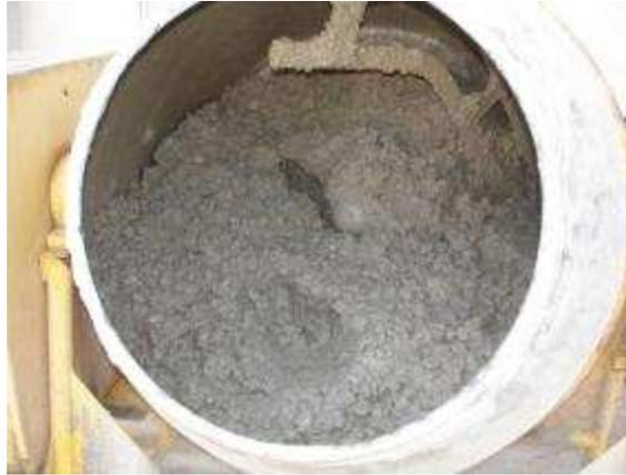
**Figura 7.9 – Mistura do concreto em betoneira elétrica**
