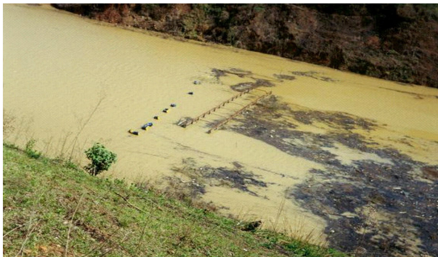
FIGURA I 14 Desaparecimento da ponte do Funil quando do enchimento da barragem da UHE-Funil, em Lavras, MG.
