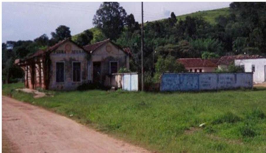
FIGURA I 2 Antiga estação da Estrada de Ferro Oeste de Minas em Pedra Negra, município de Bom Sucesso MG. Fonte: Prefeitura Municipal de Ijaci.(2001).
