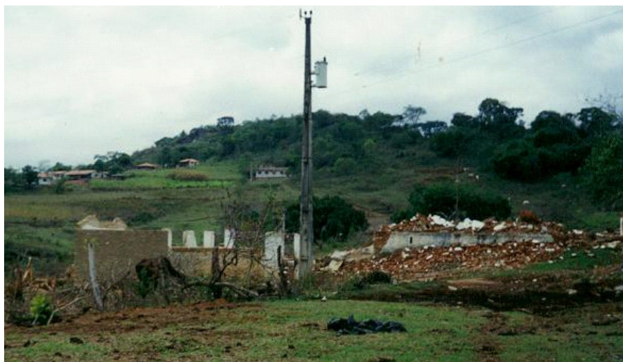
FIGURA I 15 Início desocupação da Comunidade do Barreiro, em Ijaci, MG. Fonte: Prefeitura Municipal de Ijaci, MG (2001).
