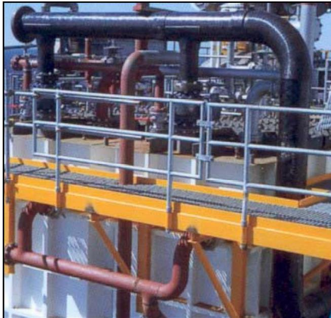
Figura 7 – Tubulação de PRFV em plataforma *offshore* (Ameron International, 2006).
