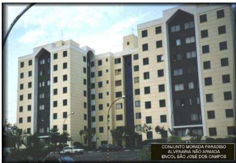
Figura 2.9 - Conjunto Morada do Paraíso, construído pela Encol em alvenaria não armada – Fonte: Silva (2005).
