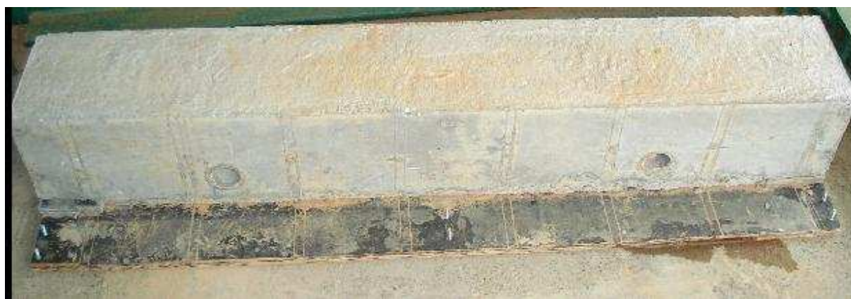
Figura 3.20 - Viga de transporte da alvenaria.
