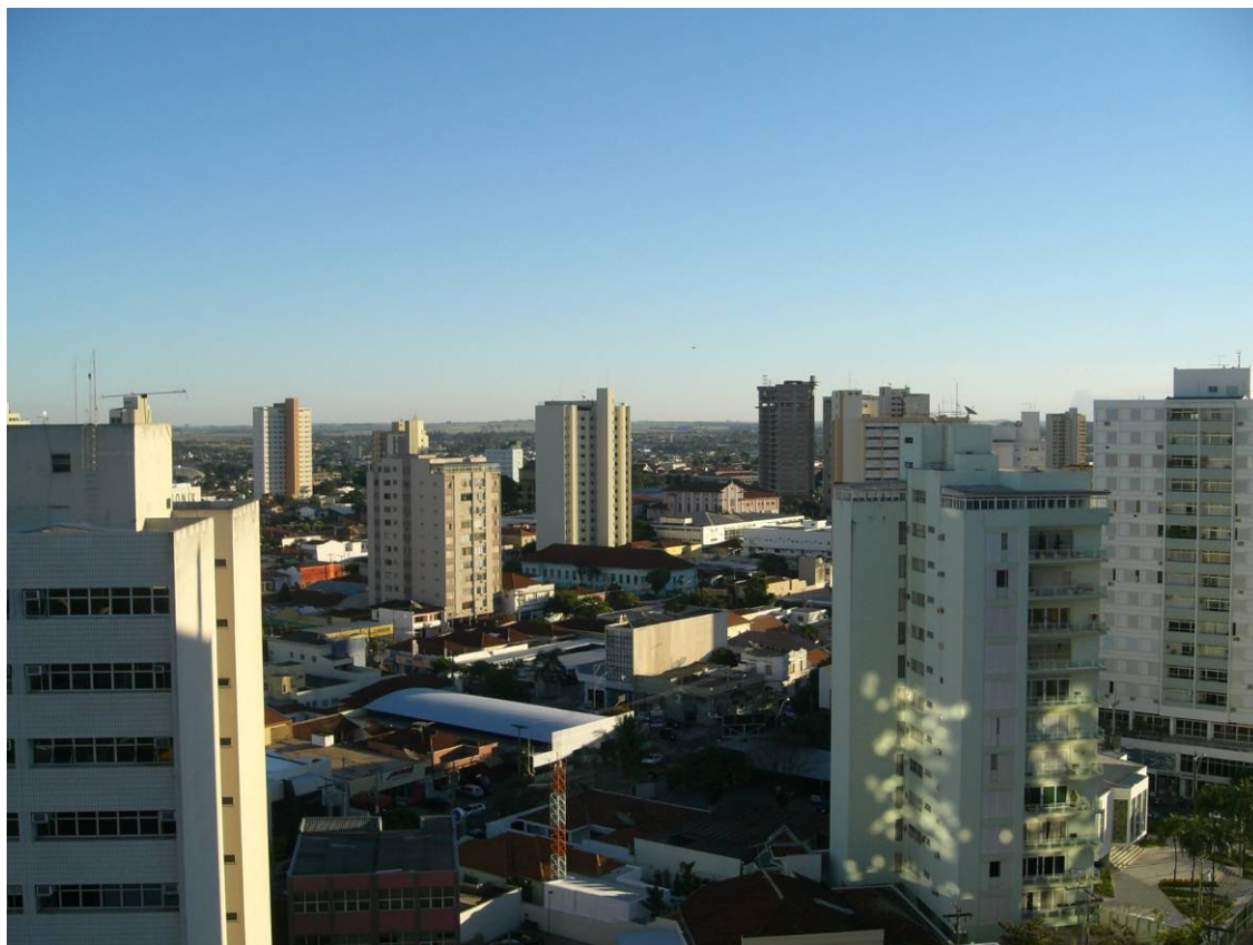
Figura 24 - Vista aérea dos edifícios da área central urbana Fonte: Arquivo Pessoal
