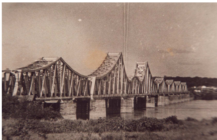
Foto 11: Conclusão da ponte ferroviária Francisco de Sá, 1940. Acervo Foto Cine Prudente, 2007.
