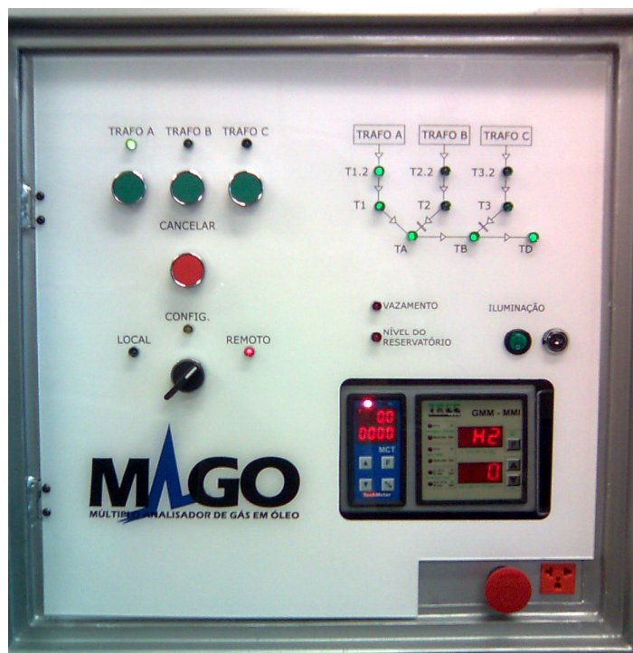
Figura 4.5 – Interface de comando local.
