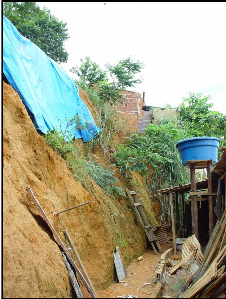
Figura 3.3 – Proteção do talude com lona plástica reduzindo o potencial erosivo da chuva, Bom Jardim, Ipatinga.
