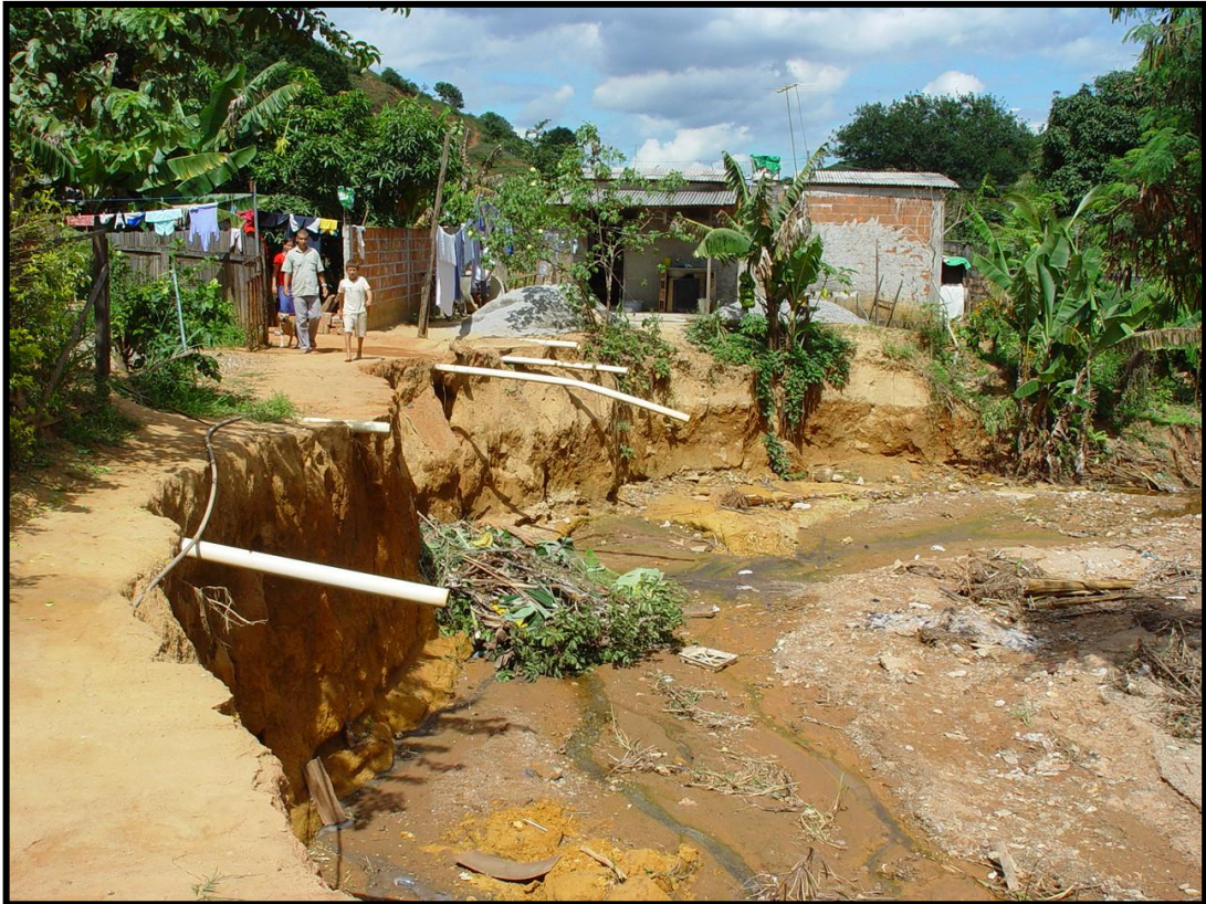
Figura 3.5 – Erosão marginal avançada, lançamento de esgoto e assoreamento do curso d'água em função da ocupação urbana inadequada.
