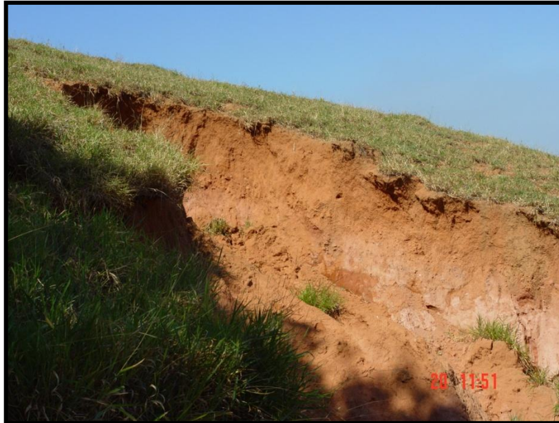
Figura 2.14 – Voçoroca provocada pelo escoamento subsuperficial no município de Ipatinga.
