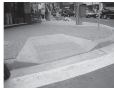
Nos rebaixamentos de calçadas, em cor contrastante com a do piso, com largura de 0,25 a 0,50m, afastada 0,50m do término da rampa.
