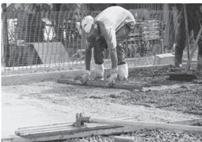
**2.** Descarga, espalhamento e nivelamento da base de concreto (sarrafeamento)
