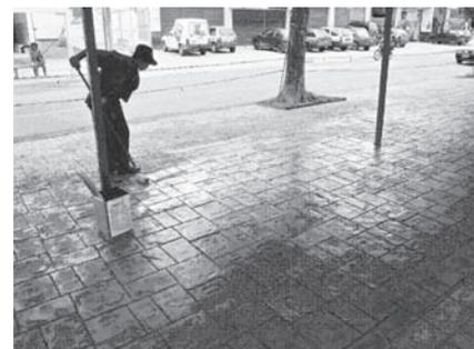
**6.** Aplicação de resina após execução de corte de junta de controle e lavagem
