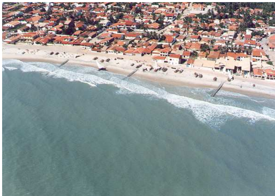
Figura 3: Obra de contenção implantada na praia
