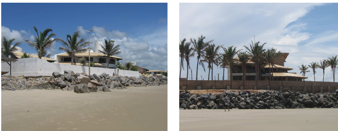
Figura 11: Presença de estruturas rígidas implantadas para proteger os imóveis do fenômeno erosivo.
