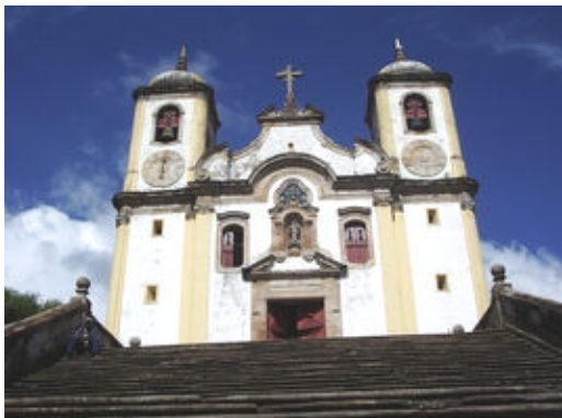
Fachada principal da Igreja de Santa Efigênia, construção atribuída à atuação direta de Chico Rei.
