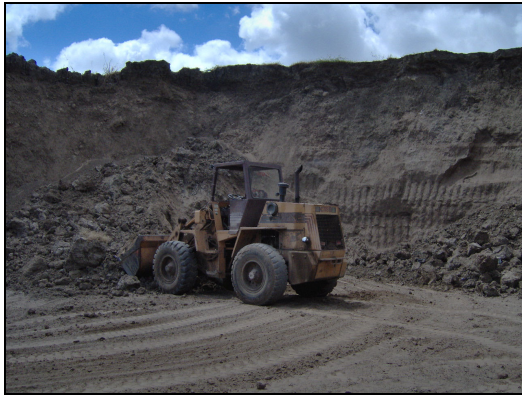
Figura 5.1 - Pá-carregadeira retirando argila.
