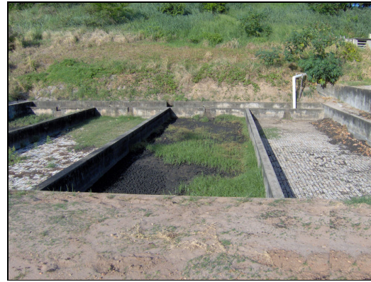
Figura 5.2 – Leito de secagem ETE-Campus.
