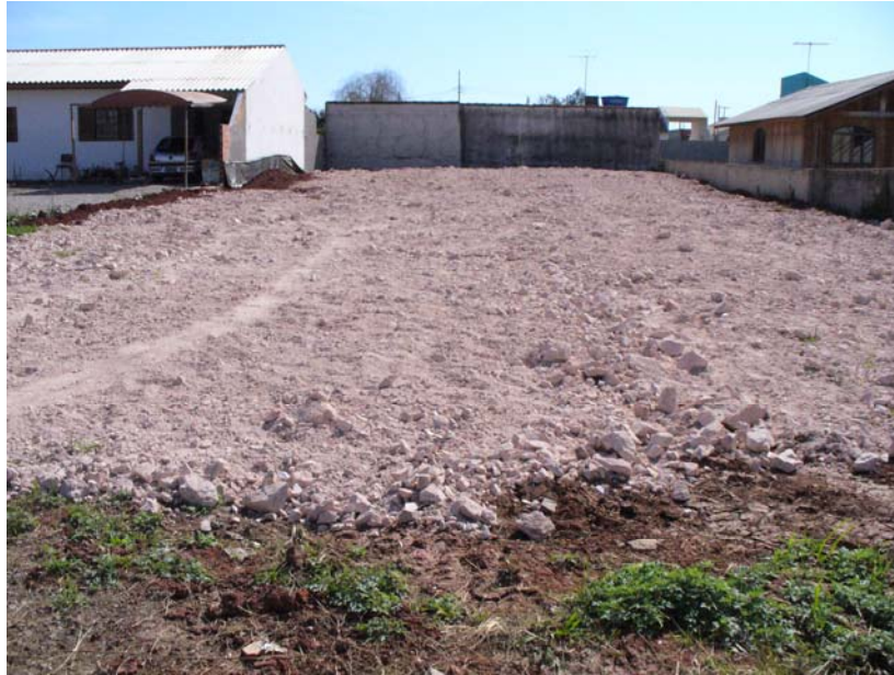
FIGURA 10 – DEPOSIÇÃO DE HORIZONTE C DE SOLO DE OUTRO LOCAL EM TERRENO DA ÁREA P-01 DO BAIRRO JARDIM PAULISTA, CAMPINA GRANDE DO SUL (PR)
