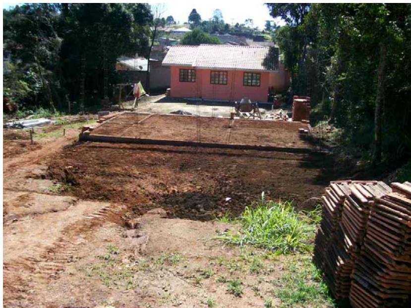
FIGURA 15 – DECAPITAÇÃO DO SOLO – NIVELAMENTO EM TERRENO DA ÁREA P-02 DO BAIRRO JARDIM PAULISTA, CAMPINA GRANDE DO SUL (PR)
