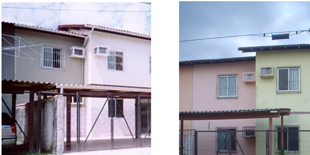
Figura 4.37 - Xavante II. Vistas da fachada do: grades nas janelas. Fonte: Fotografia do autor, novembro, 2006
