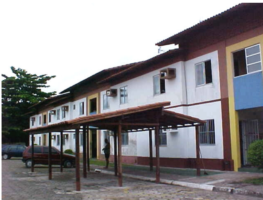
Figura 4.25 - Construção de coberturas para veículos com invasão de calçadas, em frente a bloco interno. Fonte: Fotografia do autor, 2006.
