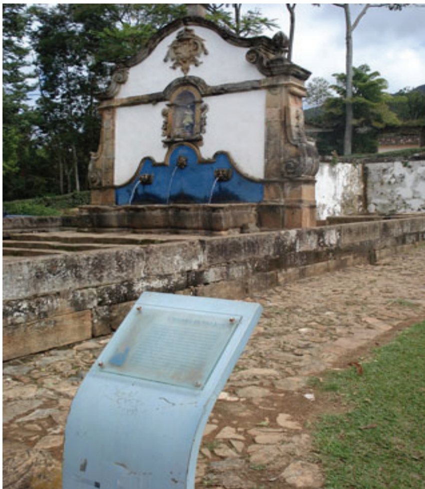
Figura 11: Chafariz São José (construído em 1749)
