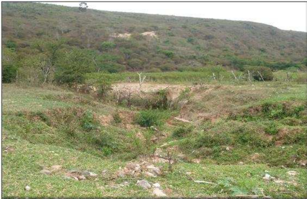
Foto 21: Antigo nível de base localizado sobre a barragem rompida, no qual os depósitos colúvio-aluviais foram evacuados. Nota-se em micro escala a inversão do relevo, convertendo a área deposicional em nova área fonte.
