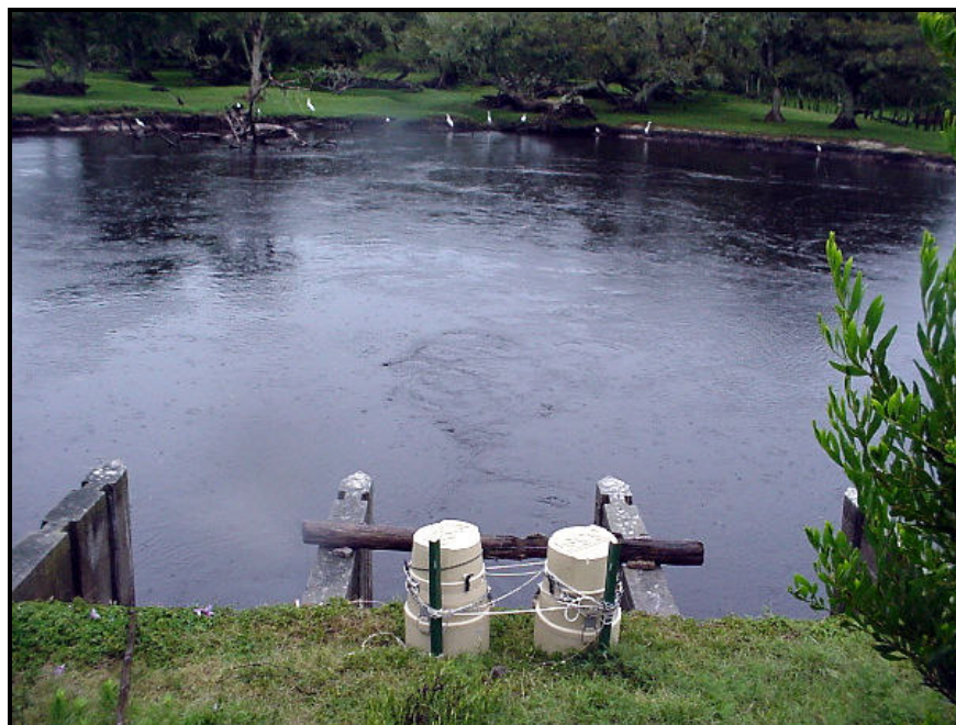
Figura 4.8 – Aspecto do canal de drenagem do Taim no local da comporta. (Fonte: PELD, 2005).
