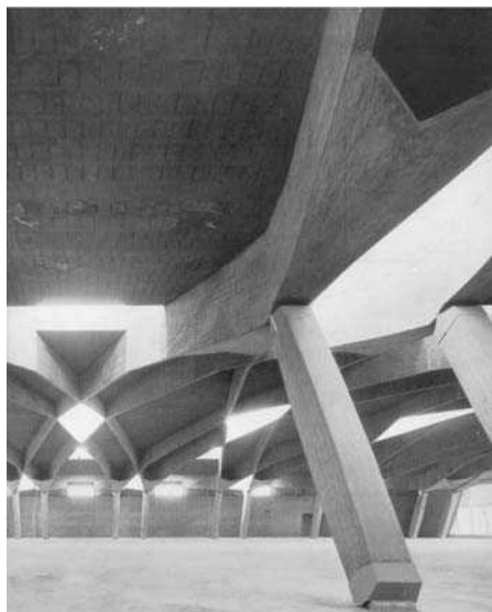
Fig.745: Detalhe do sistema estrutural
