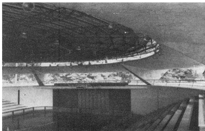
Fig.520: Vista do interior - arquibancadas
