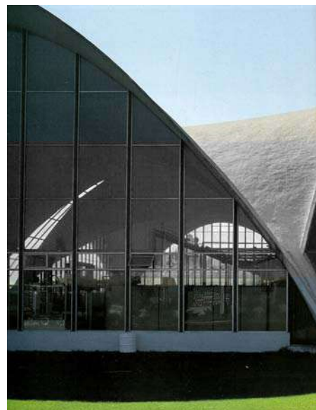
Fig.672: Detalhe da frente do edifício. Estado atual.
