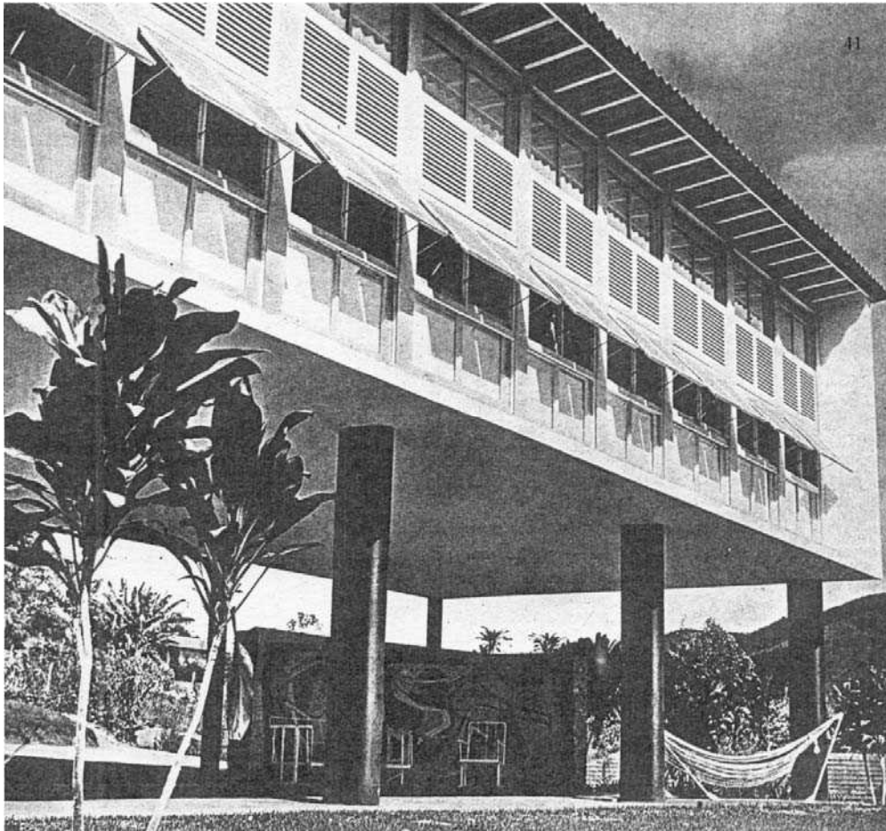
Fig.22: Casa de Campo em Nogueira - Terraço
