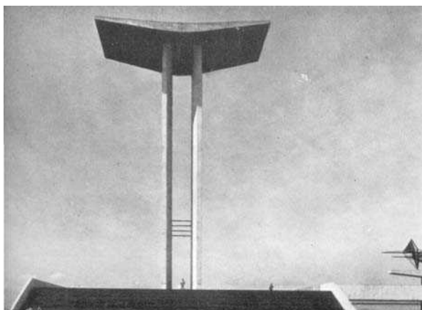
Fig.765: Vista frontal do pórtico.
