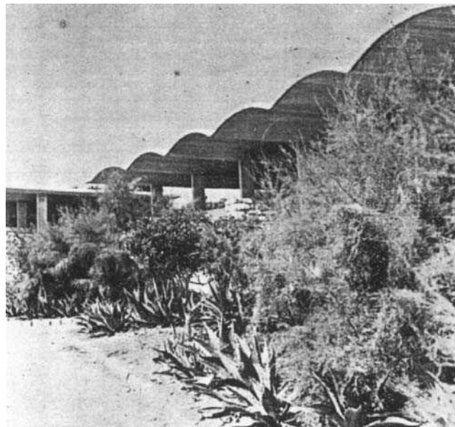
Fig.166: Vista do sistema de cobertura
