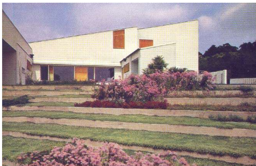
Fig.472: Fachada Leste – vista do jardim em frente aos quartos
