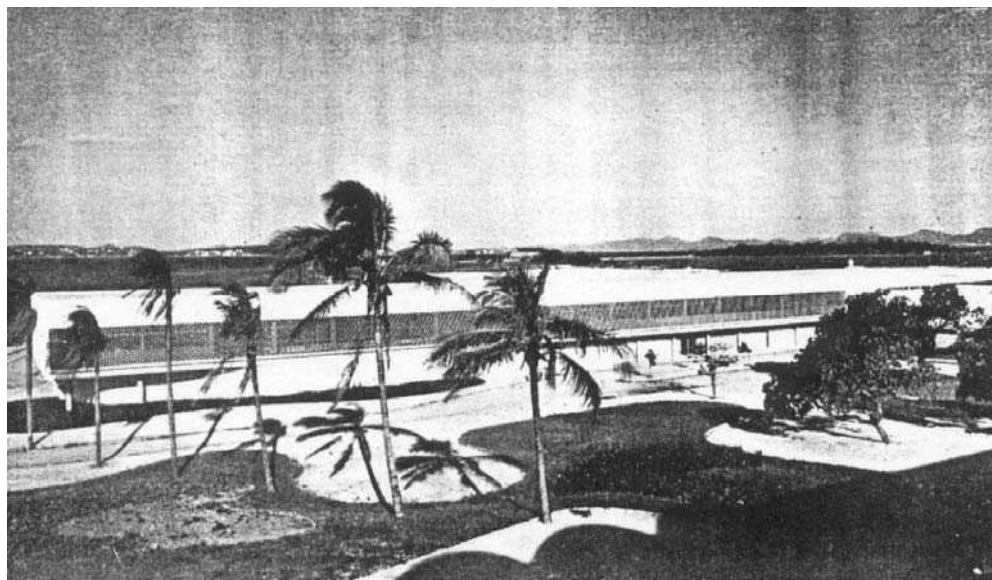
Fig.207: Fachada sudoeste protegida com elementos vazados de cerâmica
