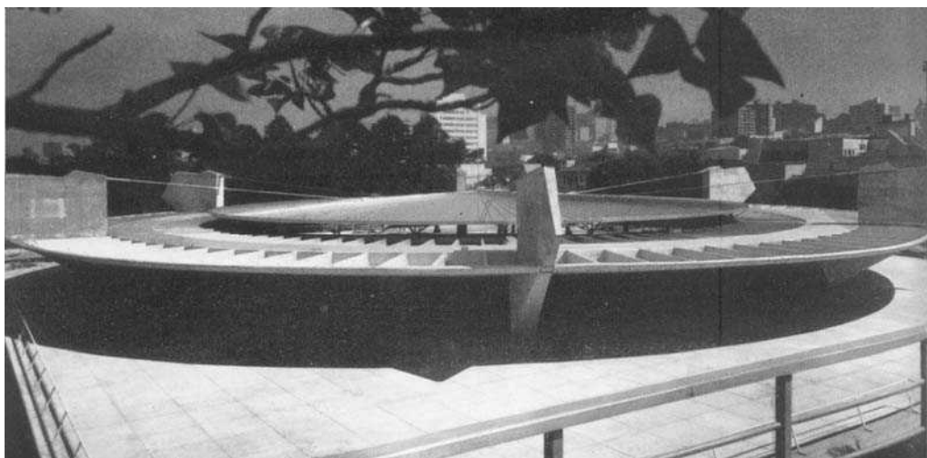
Fig.513: Vista da laje do terraço e sistema de cobertura.
