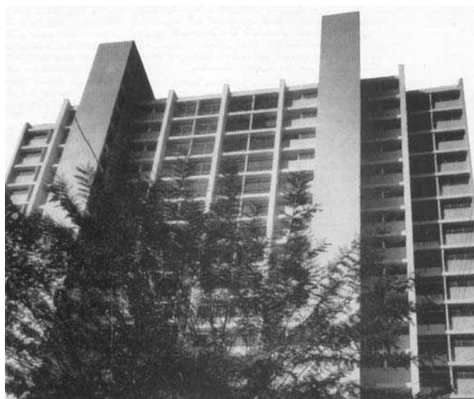
Fig.353: Vista das torres de circulação vertical
