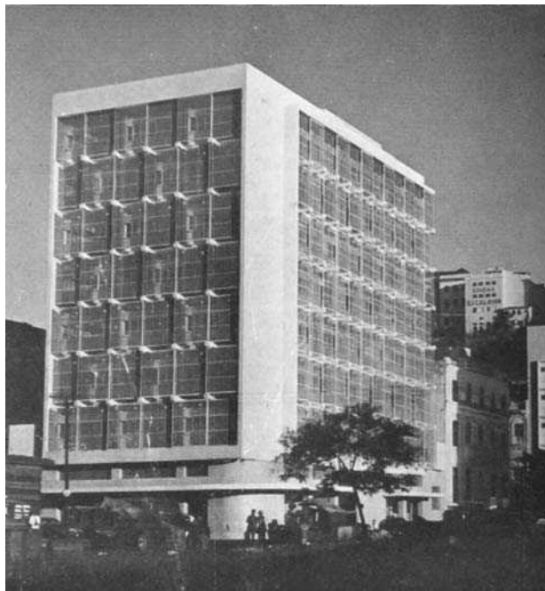
Fig.99: Vista de duas fachadas
