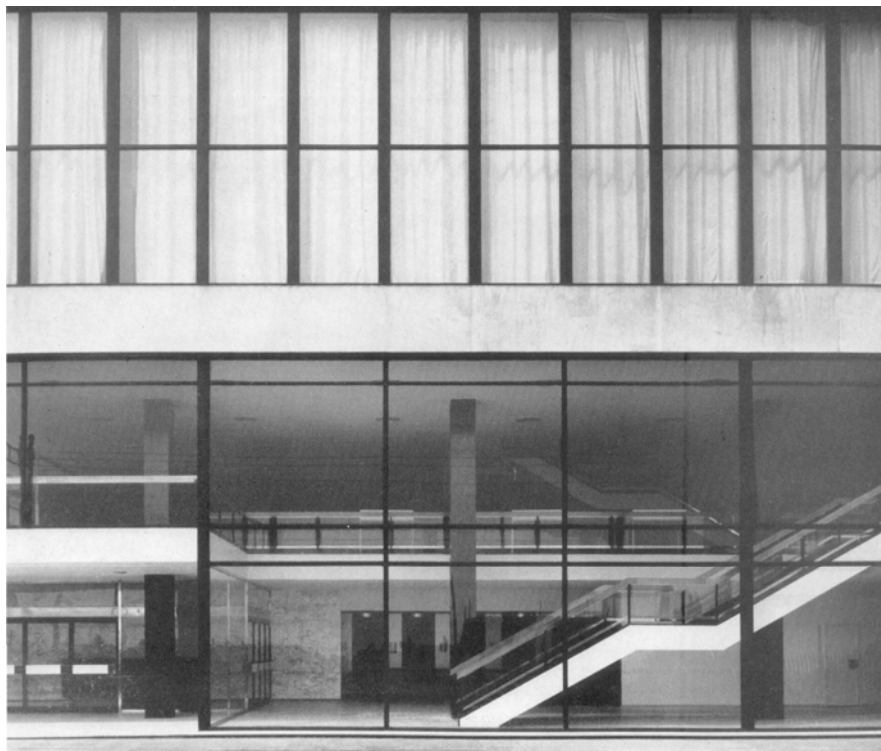
Fig.719: Hall de entrada
