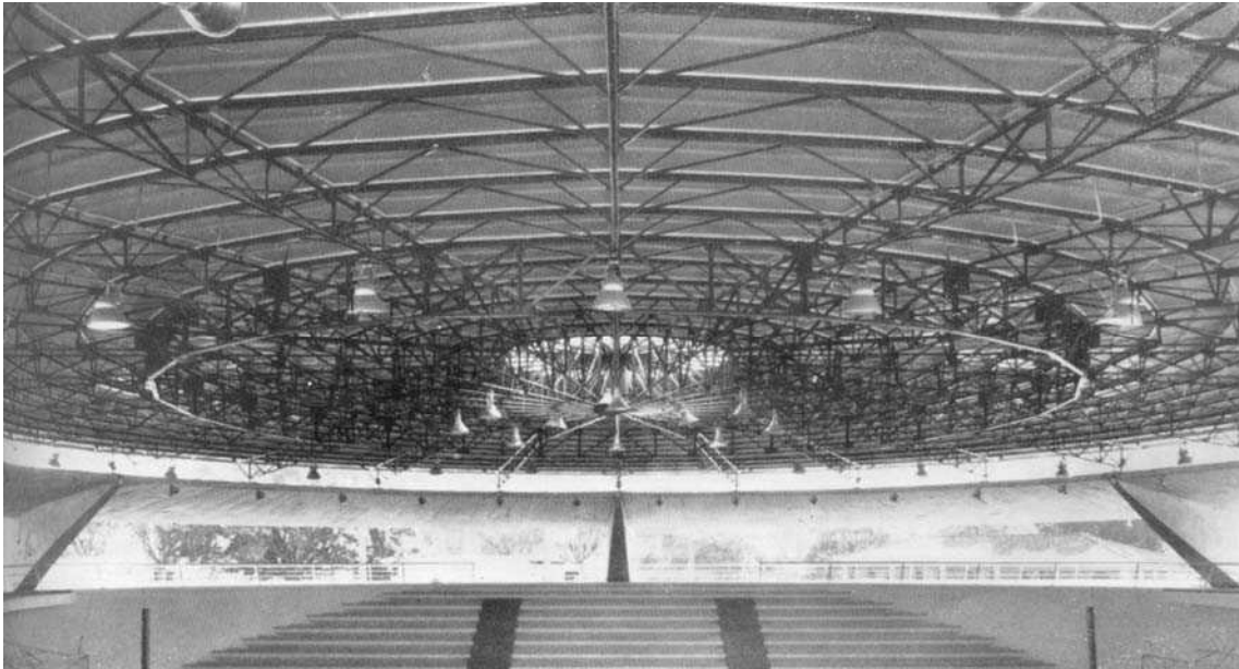
Fig.516: Vista da laje do terraço e sistema de cobertura.
