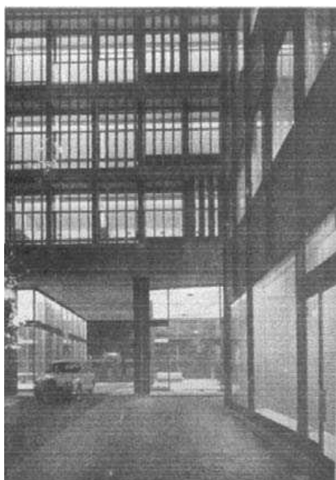
Fig.357: Passagem no térreo
