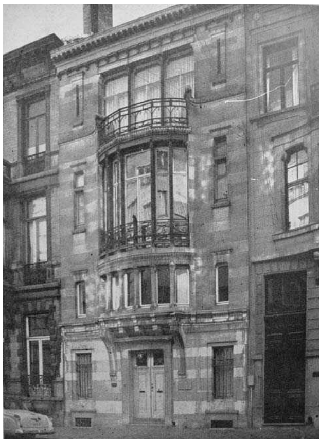
Fig.446: Antigo Hotel Tassel, 1892-1893, fachada.
