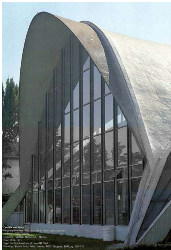
Fig.674: Vista da frente do edifício. Estado atual
