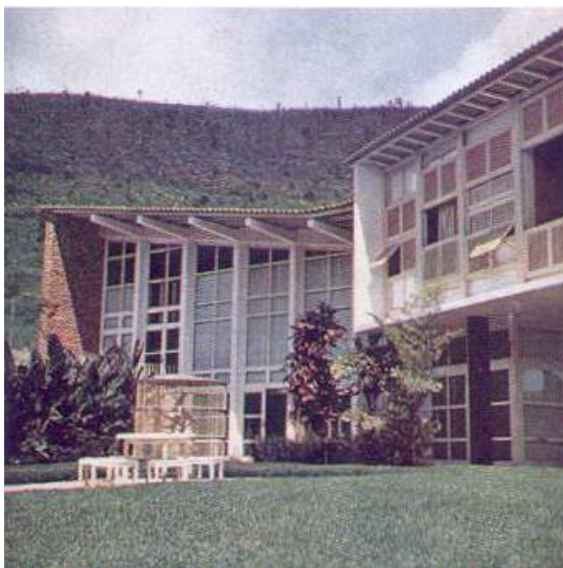
Fig.30: Casa de Campo em Nogueira – Terraço
