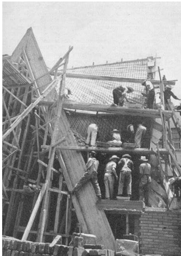
Fig.680: Montagem da armadura
