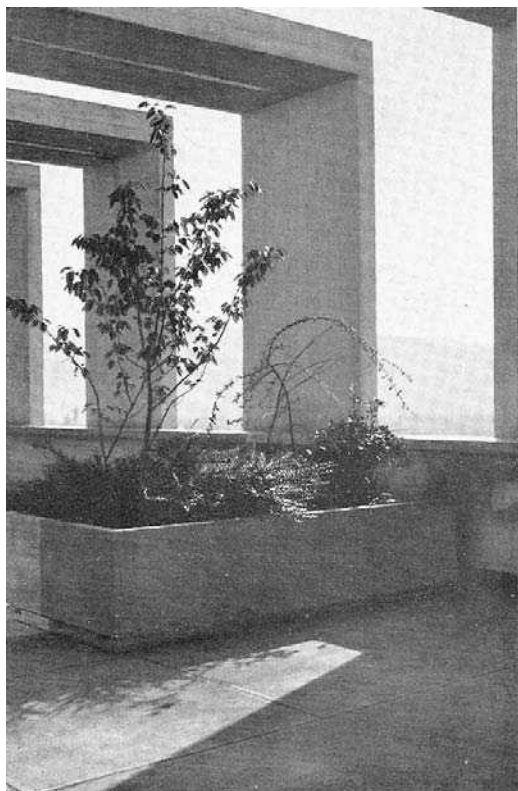
Fig. 649: Detalhe terraço jardim.
