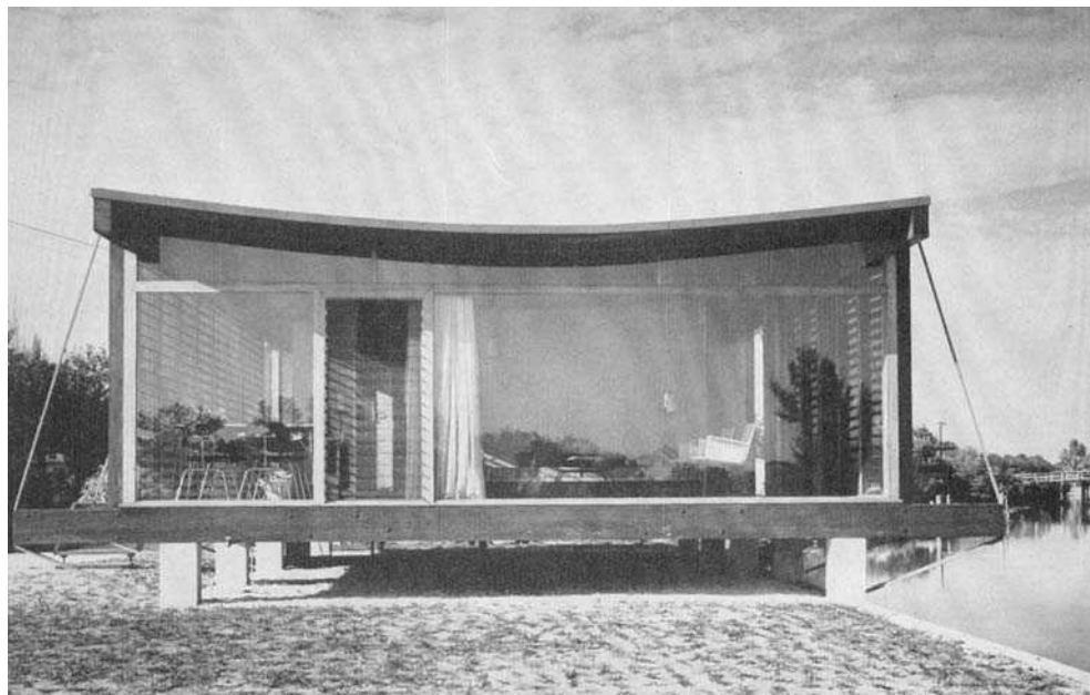
Fig.261: Vista da fachada sul
