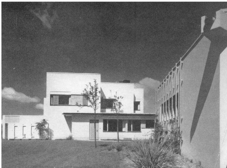
Fig.479: Fachada Norte – Os cômodos de serviço são acomodados em dois pavimentos
