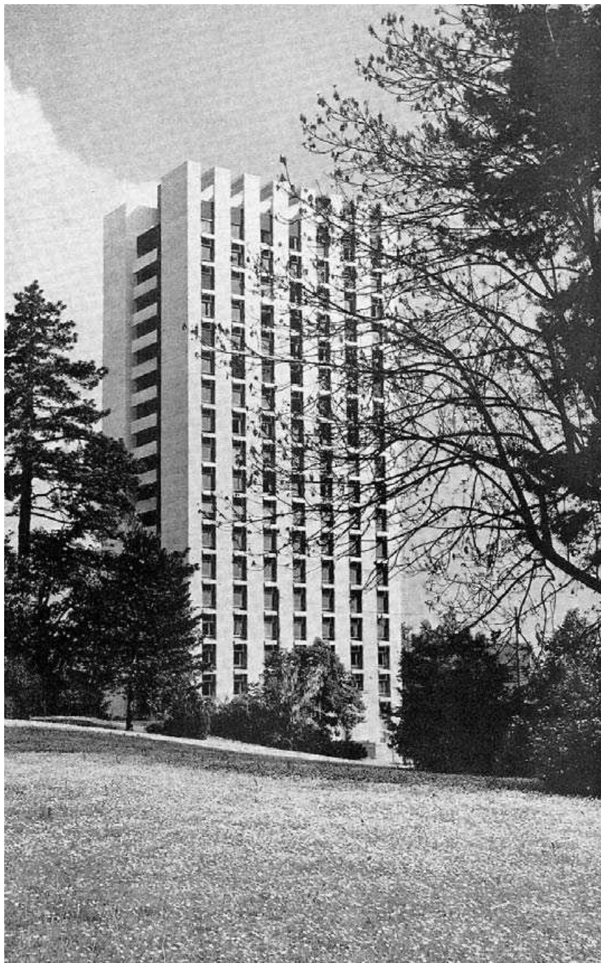
Fig.642: O alojamento das enfermeiras – Vista a partir do estacionamento do Hospital – Fachada noroeste
