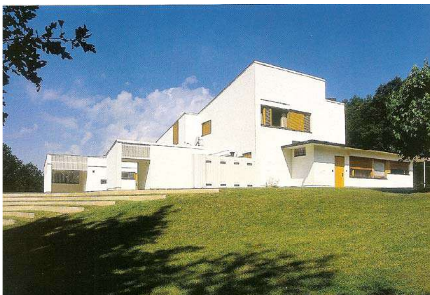
Fig.471: Fachada leste- Escada de grama e quarto de hóspedes em primeiro plano
