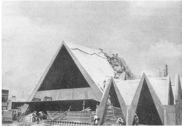
Fig.678: Vista externa da nave principal em construção
