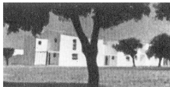
Fig.777: Vista do conjunto de moradias
