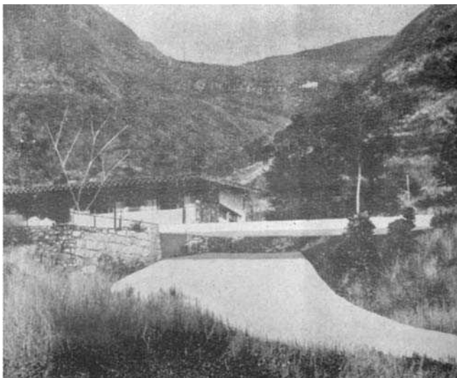
Fig.277: Vista da ponte
