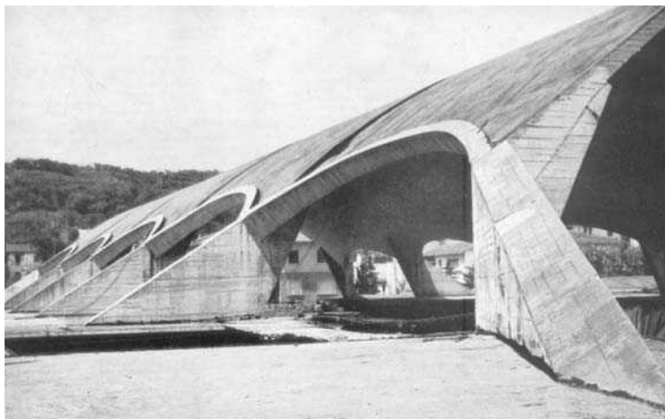
Fig.172: Vista lateral dos pilares
