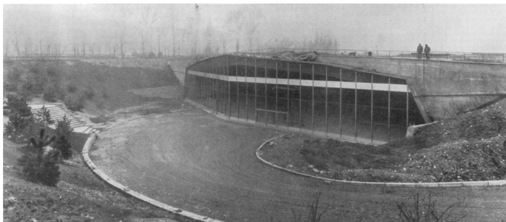
Fig.750: Vista externa – área do parque
