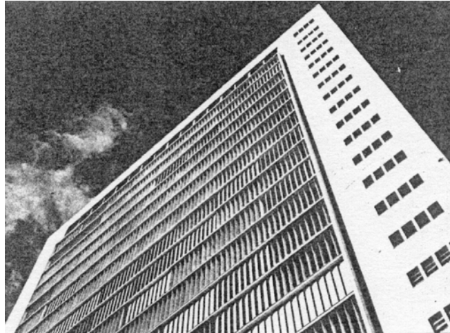
Fig.50: Detalhe do painel de brises da fachada Norte
