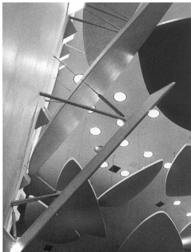
Fig.422: Detalhe de fixação dos refletores acústicos.
