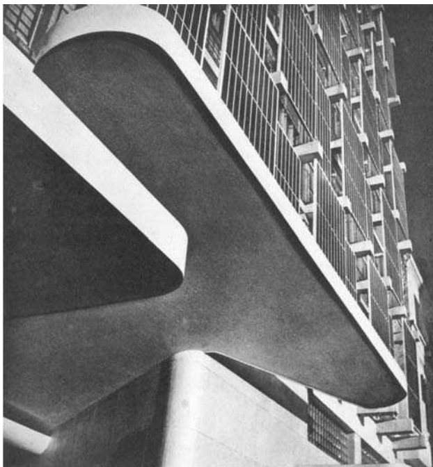
Fig.102: Marquise de entrada
