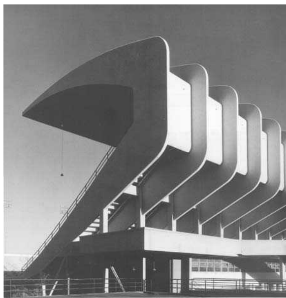
Fig.410: Vista lateral das tribunas – Pórticos de concreto armado.
