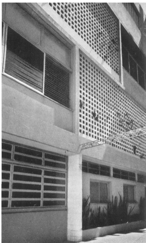
Fig.577: Detalhe da fachada posterior.
