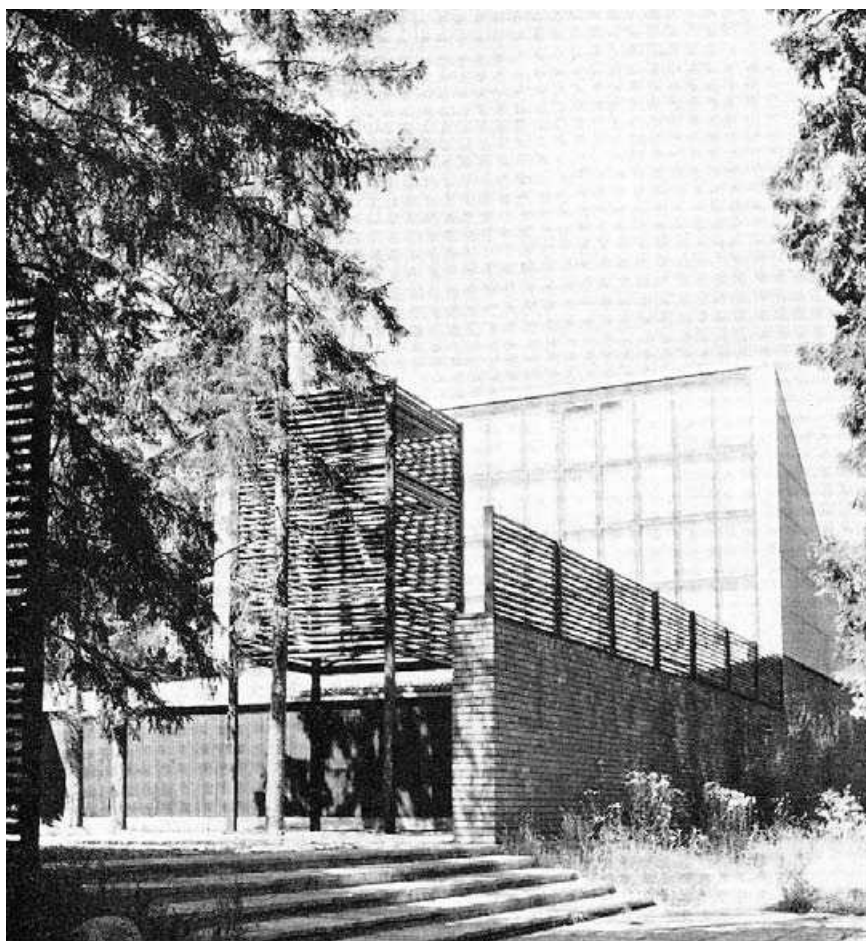
Fig.607: Capela da Vila universitária de Otaniemi – Escada de acesso ao pátio.
