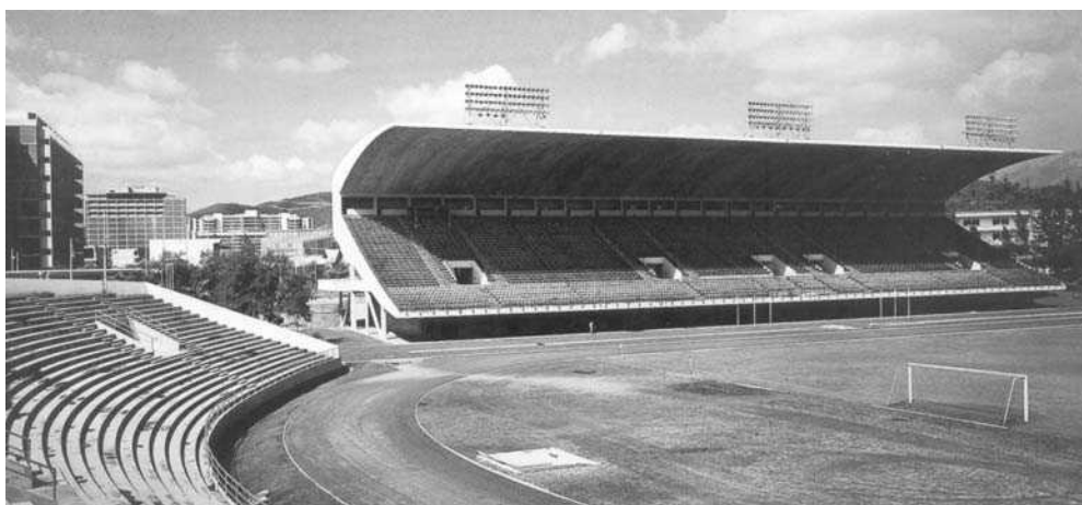
Fig.411: Estádio –arquibancadas - Vista geral.
