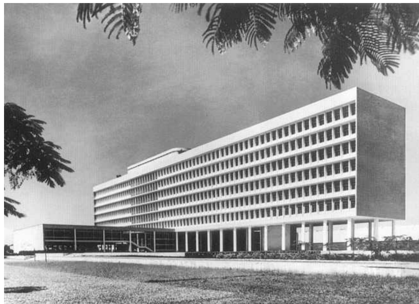
Fig.398: Vista da fachada noroeste.
