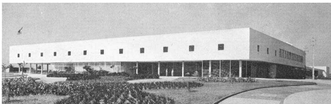
Fig.209: Vista do ambulatório – Entrada principal – Fachada sudoeste
