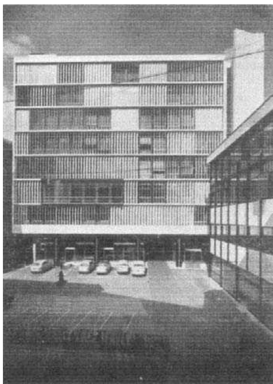
Fig.355: Fachada frontal com brises verticais
