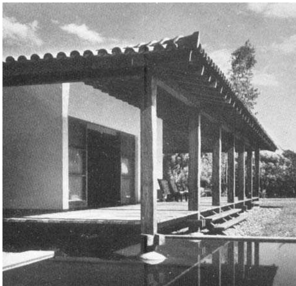
Fig.604: Detalhe da Varanda.
