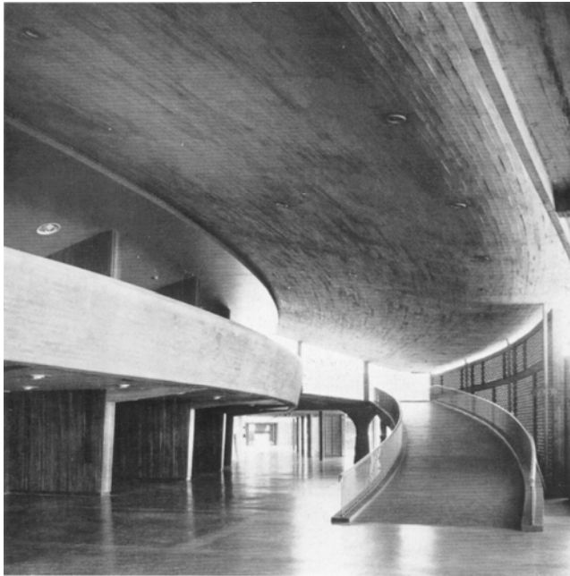
Fig.414: Aula Magna, rampas.
