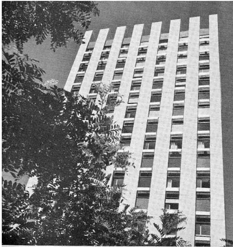
Fig.643: Detalhe da fachada oeste
