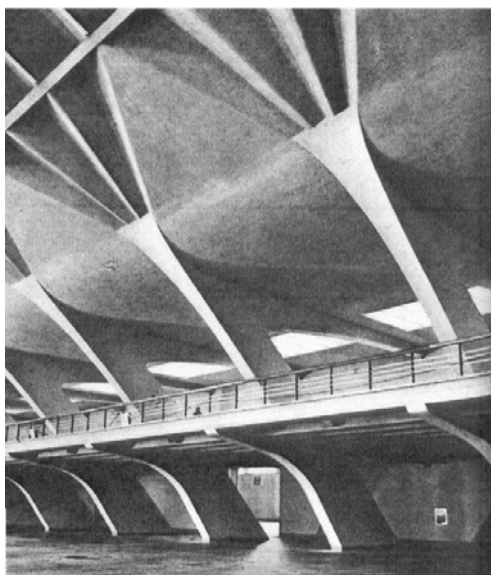
Fig.16: Palácio de Exposições de Turim - Estrutura
