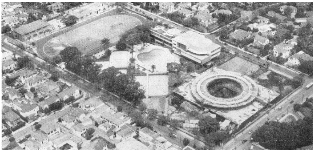
Fig.526: Vista aérea do clube
