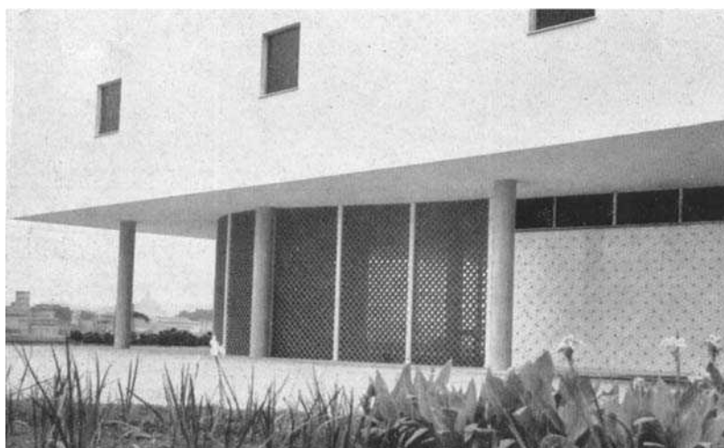
Fig.222: Ambulatório: Fachada sudoeste – Elemento vazado cerâmico – Painel de azulejo de Aylton Sá Rego
