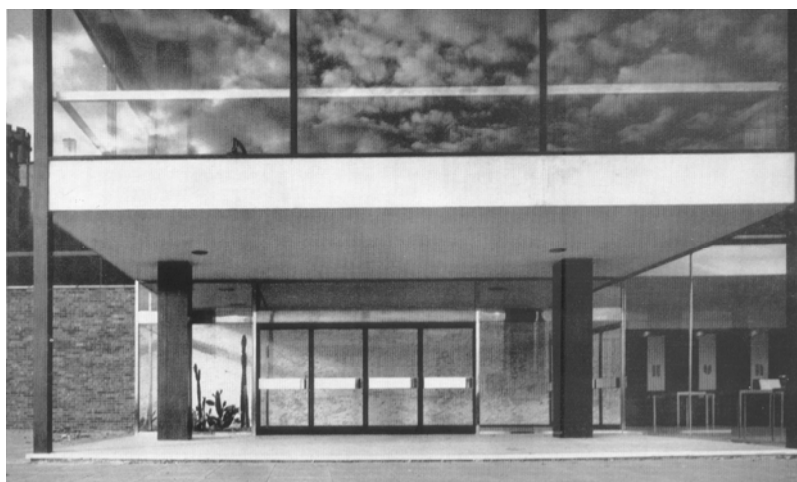
Fig.723: Hall de entrada
