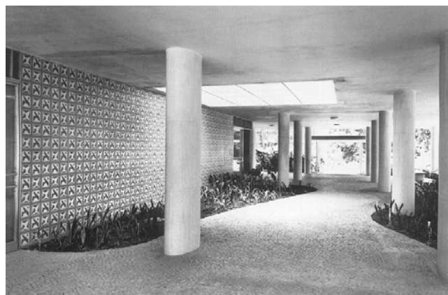
Fig.149: Vista do interior - Pátio
