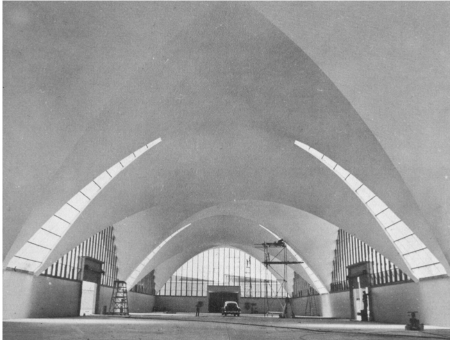
Fig.670: Vista do interior
