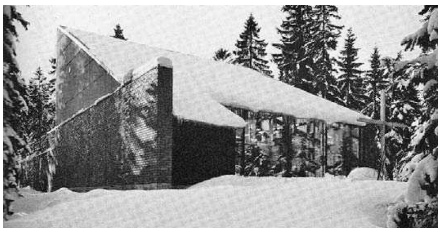
Fig.608: Vista da capela no inverno. Fachada da sacristia e do altar.
