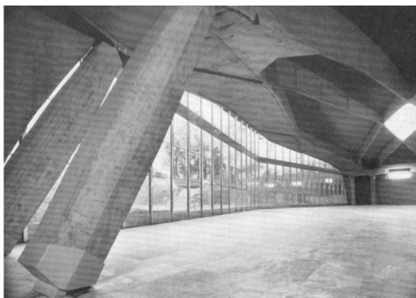
Fig.747: Pilar e vigas
