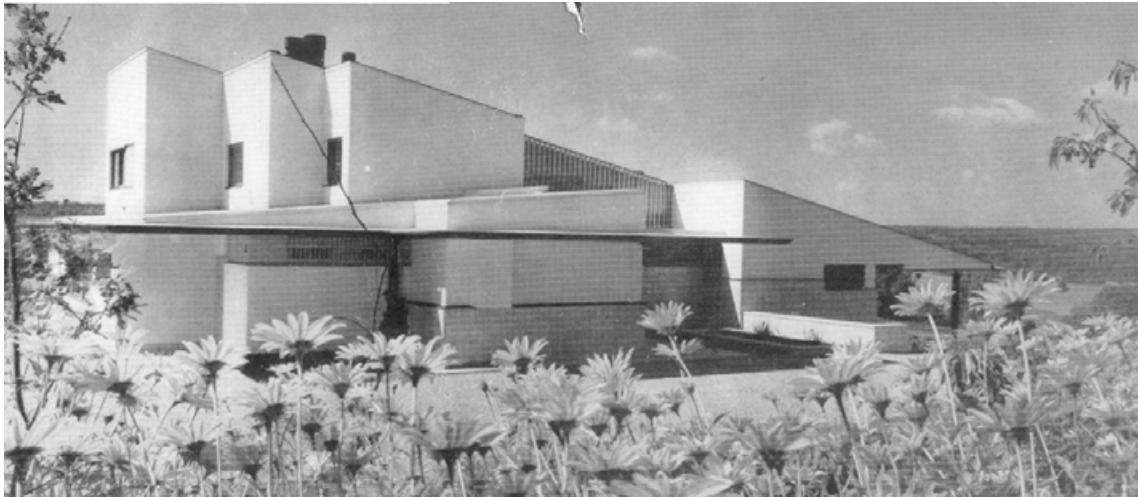
Fig.478: Face oeste – O telhado inclinado de uma única água une os vários volumes da casa
