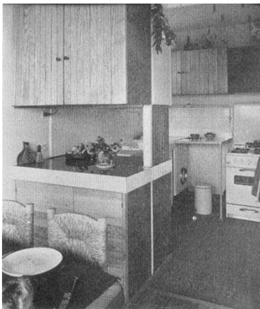
Fig. 700: Vista do interior - cozinha
