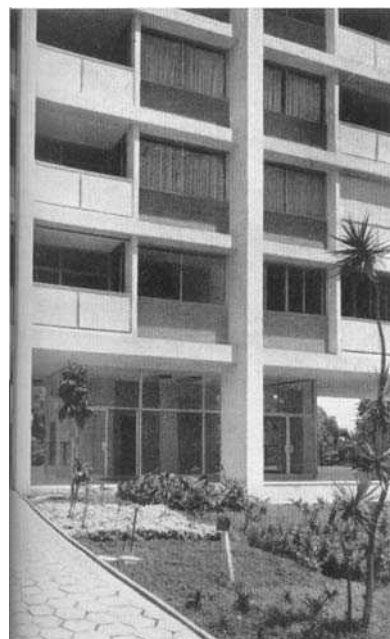
Fig.343: Varandas e painéis de fechamento
