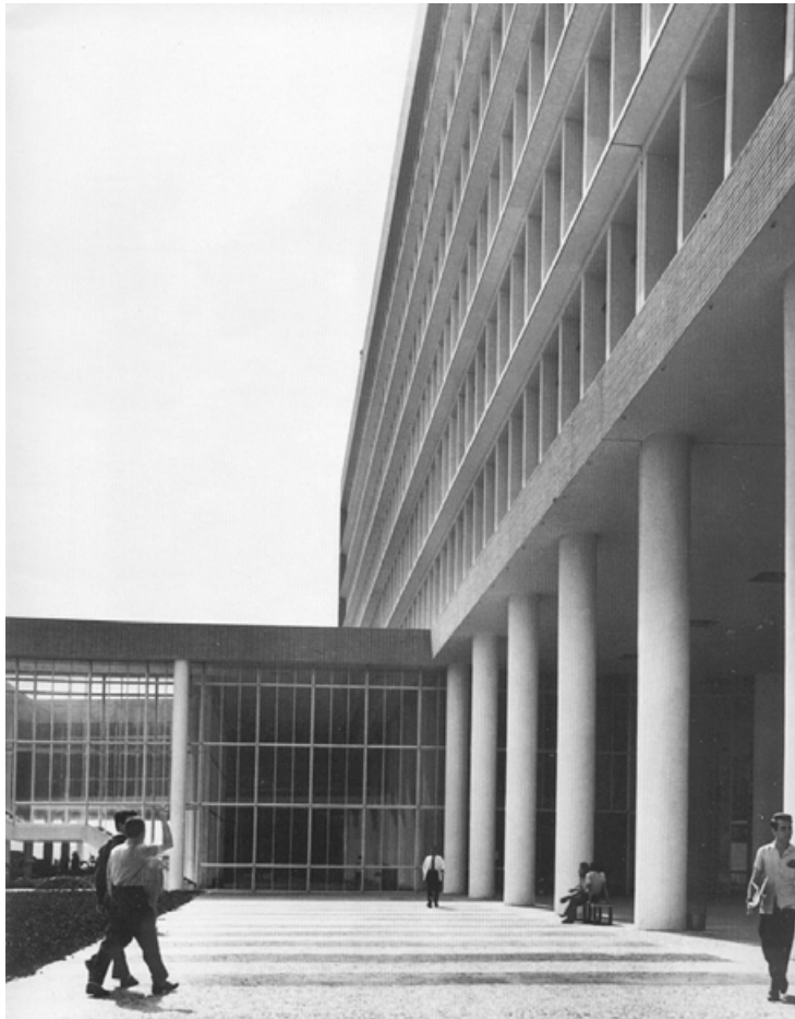
Fig.397: Vista dos pilotis da entrada.
