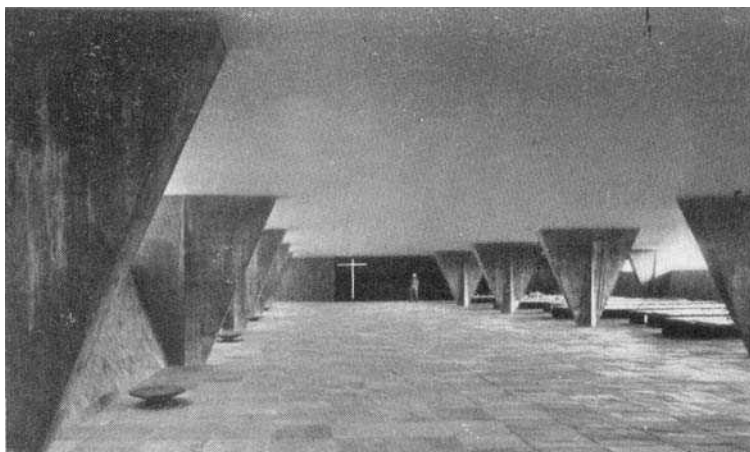
Fig.769: Mausoléu, vendo-se as colunas de concreto aparente.
