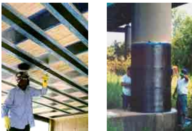
Figura 2.1 – Obras recuperadas utilizando reforço com CFC; Fonte: www.mbrace.com (2004).
